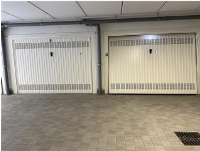
Particolare accesso box da corsello comune
