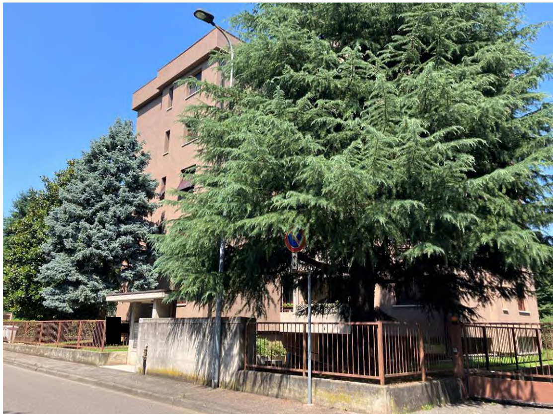
Vista fronte est
