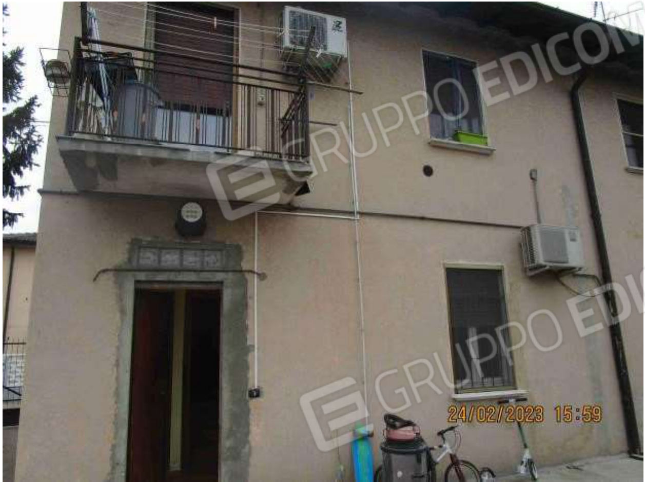
Prospetto su cortile
