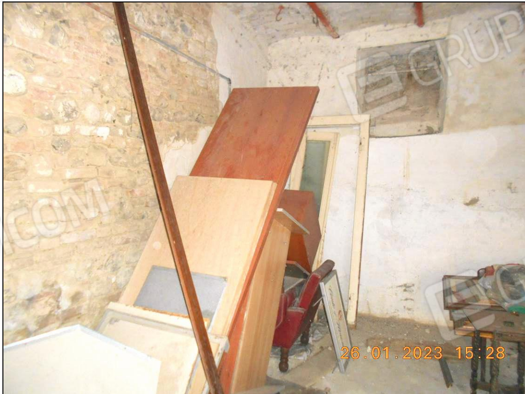
Figura 16 – vista interna della cantina al piano seminterrato
