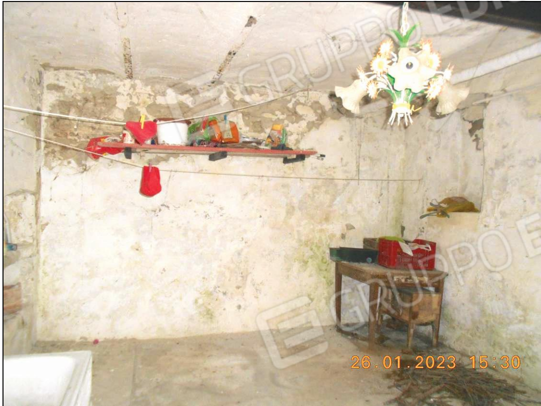
Figura 17 – vista interna della cantina al piano seminterrato
