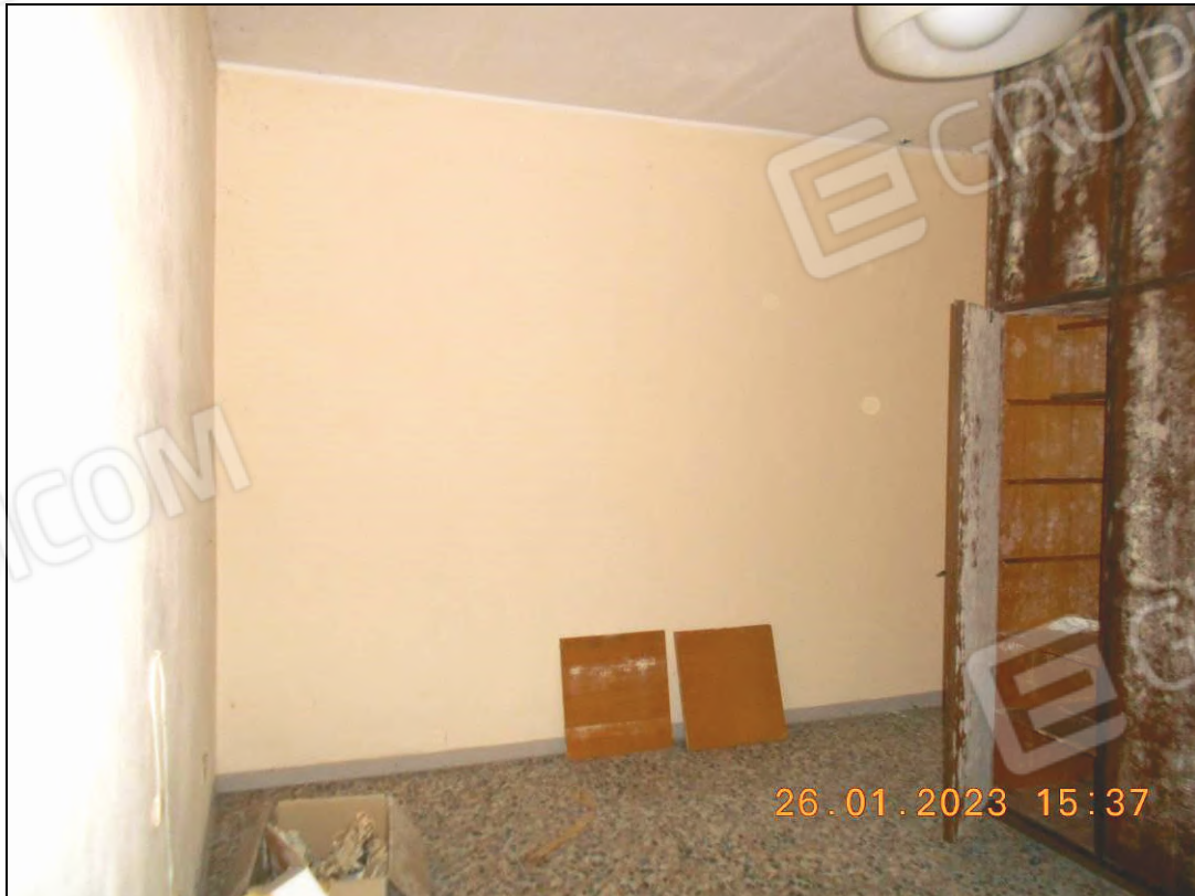
Figura 22 – vista interna della camera al primo piano
