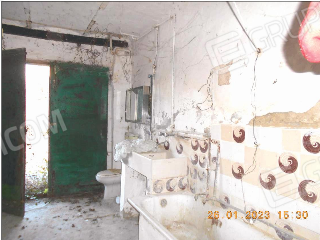
Figura 18 – vista interna della cantina al piano seminterrato
