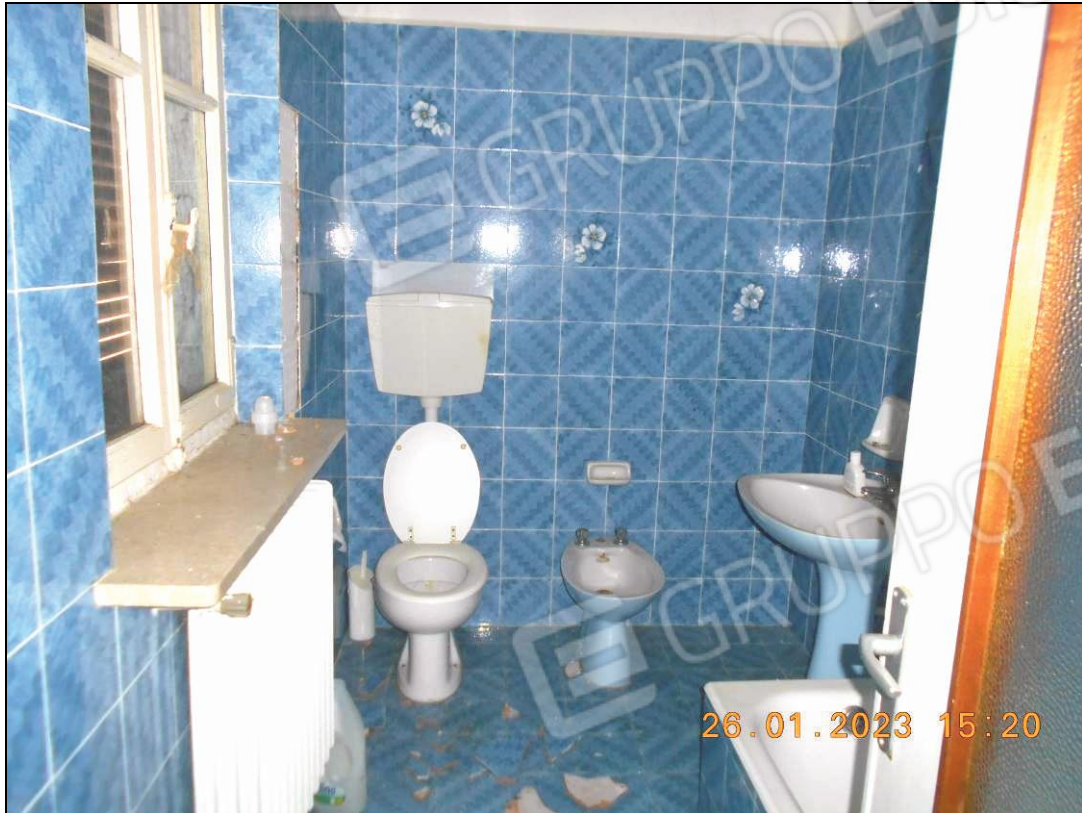
Figura 13 – vista del bagno al primo piano
