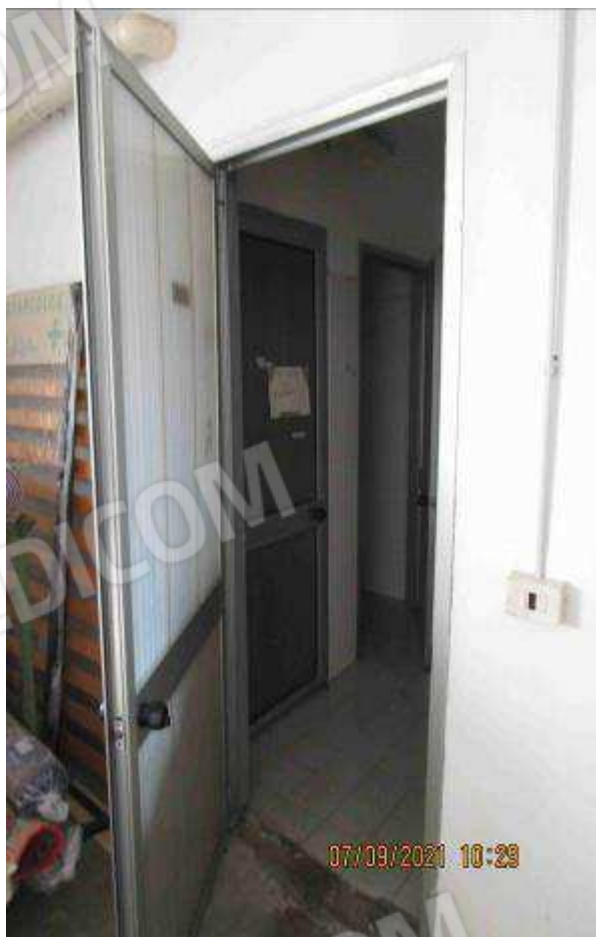
Servizi igienici - corpo su via Goia
