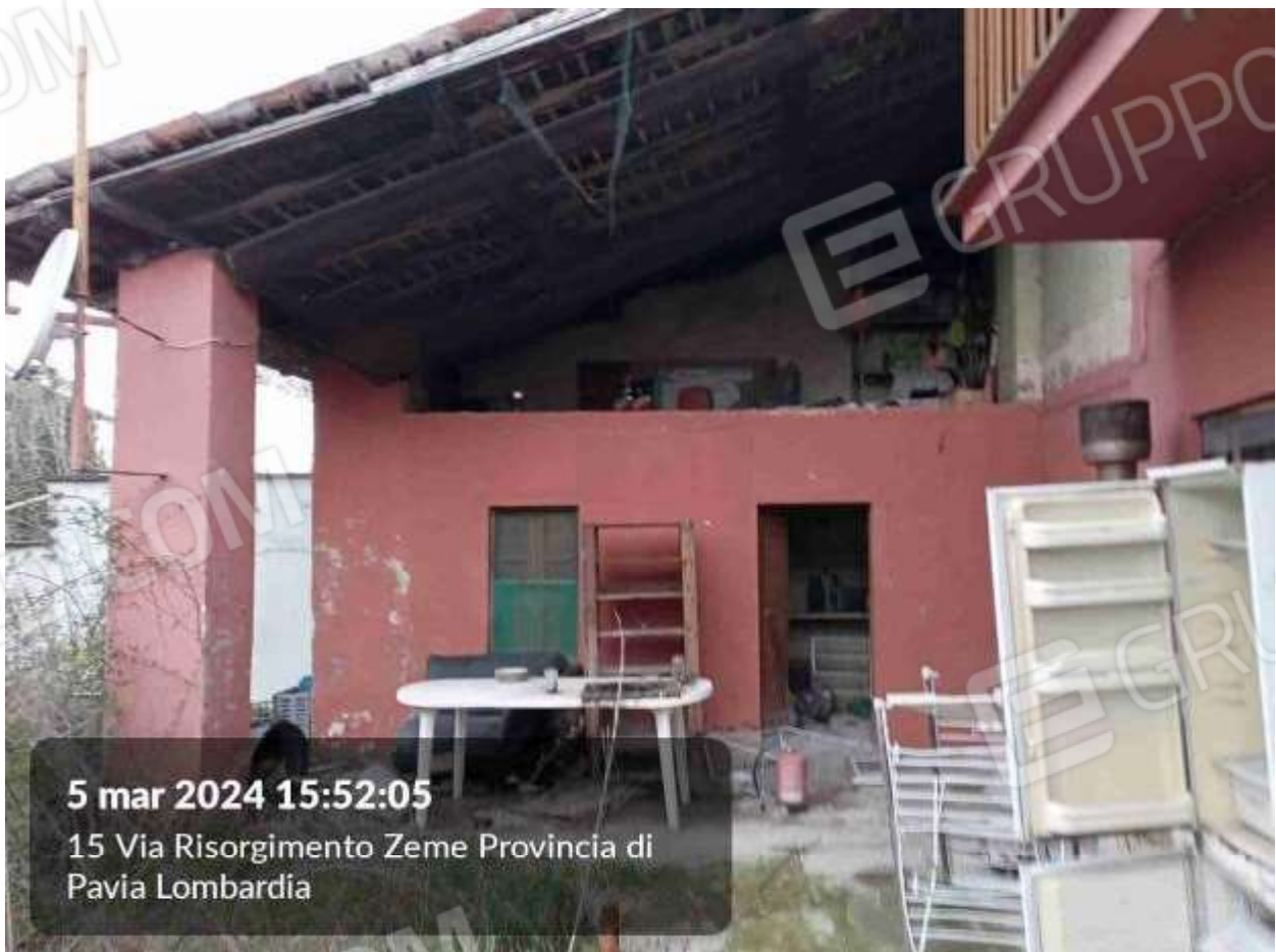
Fabbricato accessorio in aderenza alla casa
