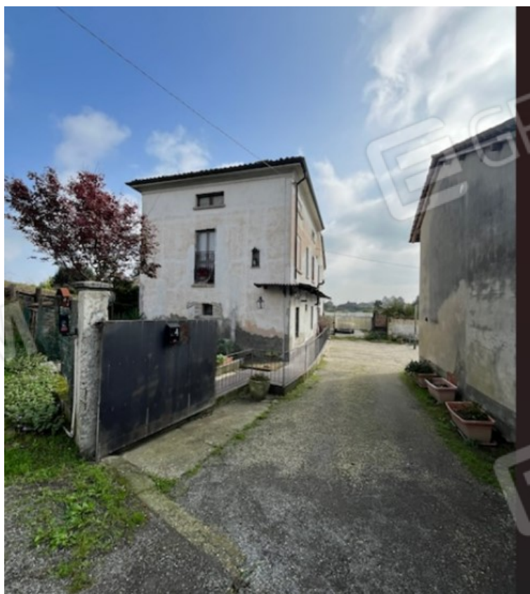
Vista accesso al fabbricato
