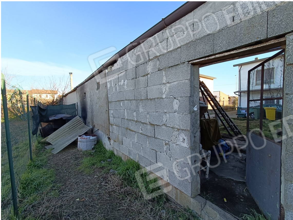
Retro autorimessa e locali accessori
