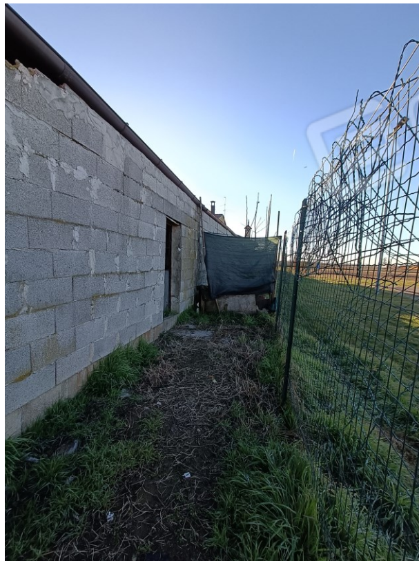
Retro autorimessa e locali accessori
