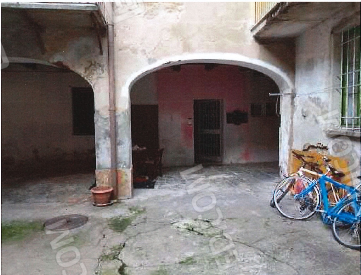
Vista del cortile interno di proprietà comune
