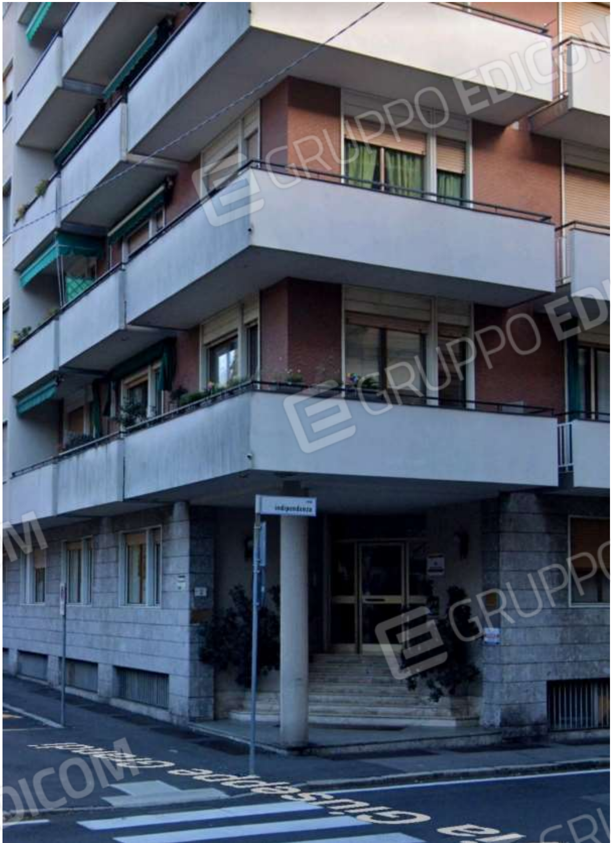
FOTO 3) Vista della scala di ingresso comune al Condominio
