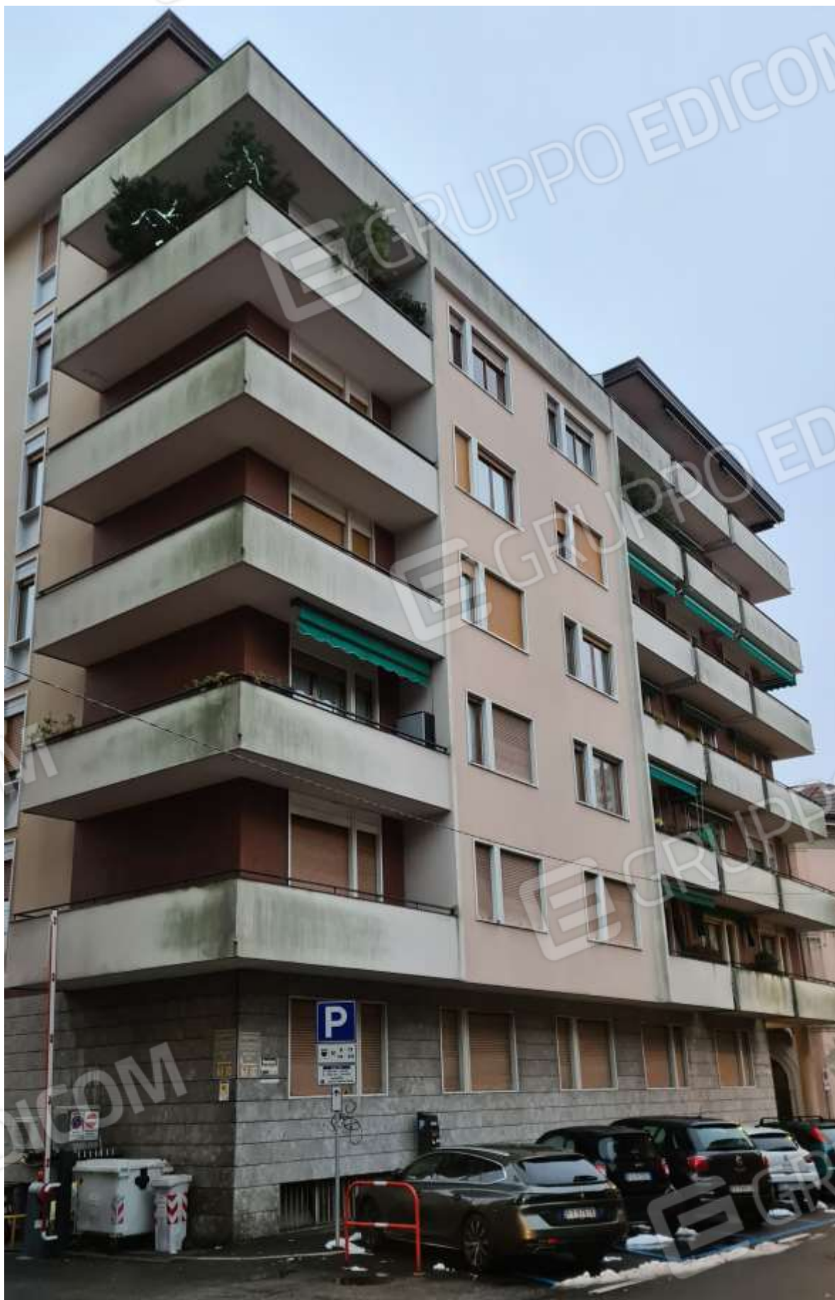
FOTO 2) Particolare del fronte su Via Grandi
