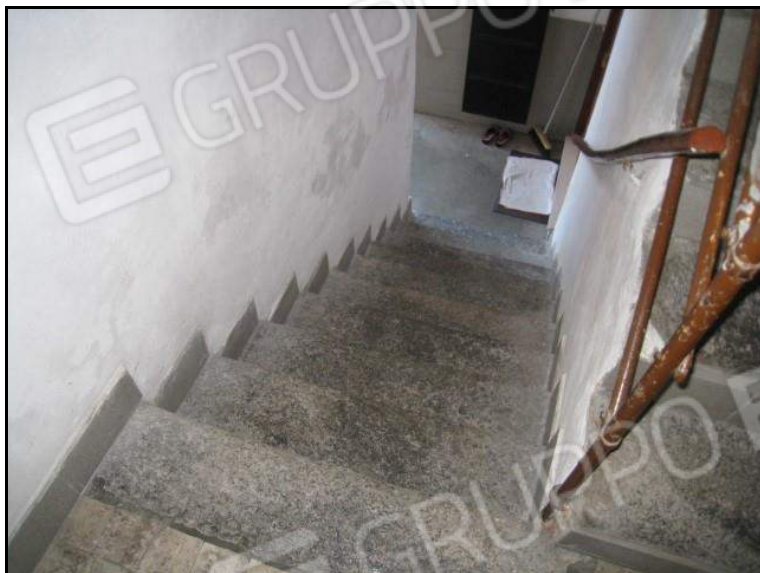
FOTO 26 ALTRA VISTA SCALA COMUNE DI COLLEGAMENTO CON IL PIANO PRIMO.
