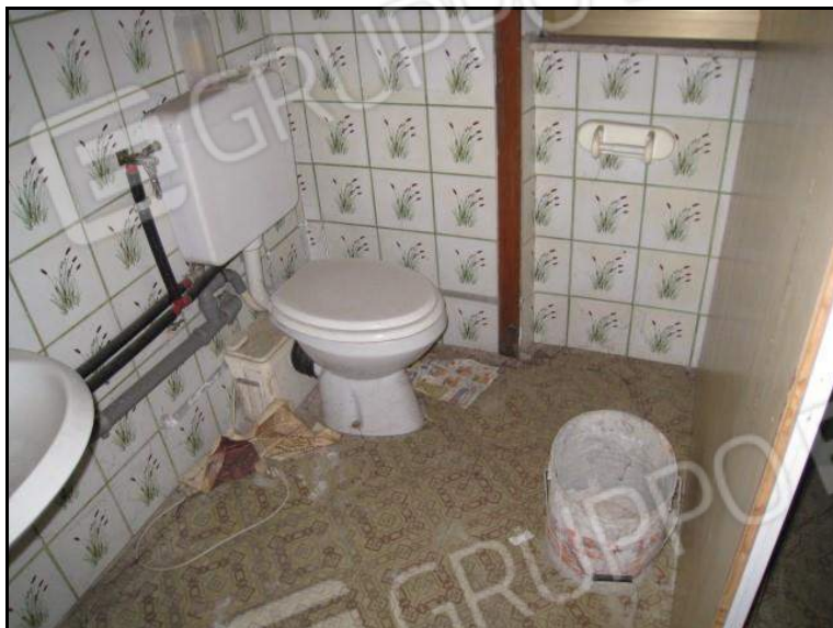
FOTO 14 PIANO TERRA PORZIONE DI ABITAZIONE U.I. MAPPALE 1458 SUB. 1 ALTRA VISTA RIPRESA ALL'INTERNO DEL BAGNO.
