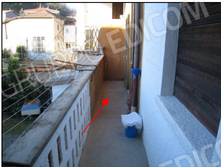
FOTO 19 PIANO PRIMO PORZIONE DI ABITAZIONE U.I. MAPPALE 1458 SUB. 1 VISTA RIPRESA VERSO SUL BALCONE DI PROPRIETA' (INDICATO CON LA FRECCIA ROSSA).
