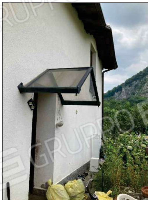
Foto 05 - FACCIATA SUD, INGRESSO
