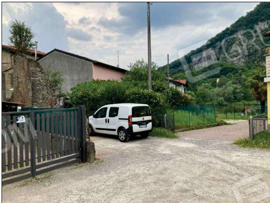
Foto 12- VISTA ACCESSO PROPRIETA' E LOCALE DEPOSITO PART. 1338-1872 DA STRADA VIA VERGA
