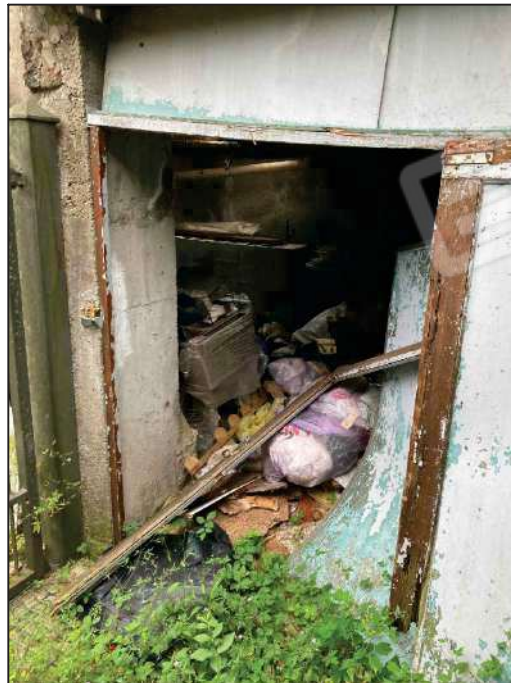
Foto 10 - ACCESSO LOCALE DEPOSITO (RUSTICO) PART. 1338-1872
