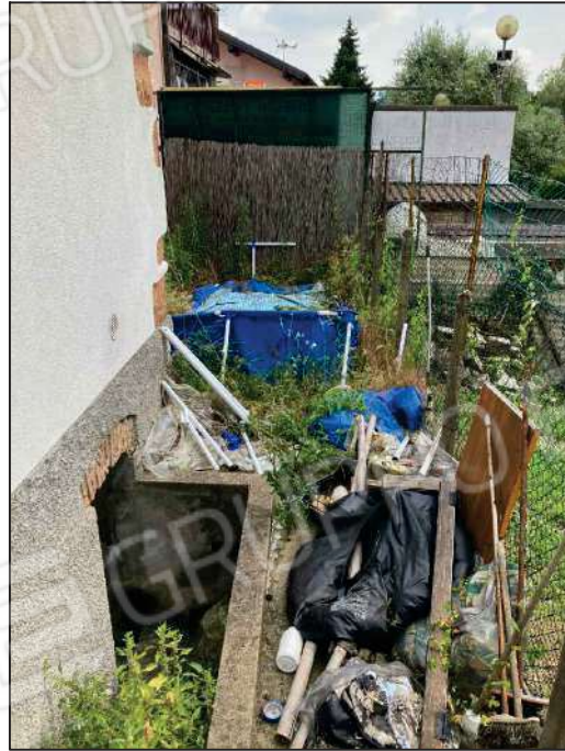
Foto 09 - FACCIATA EST, INGRESSO CANTINA
