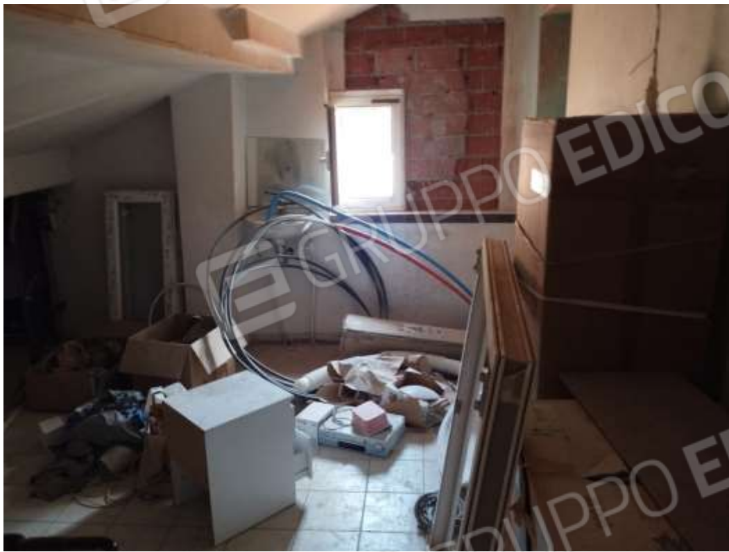
VISTA LOCALE SOTTOTETTO
