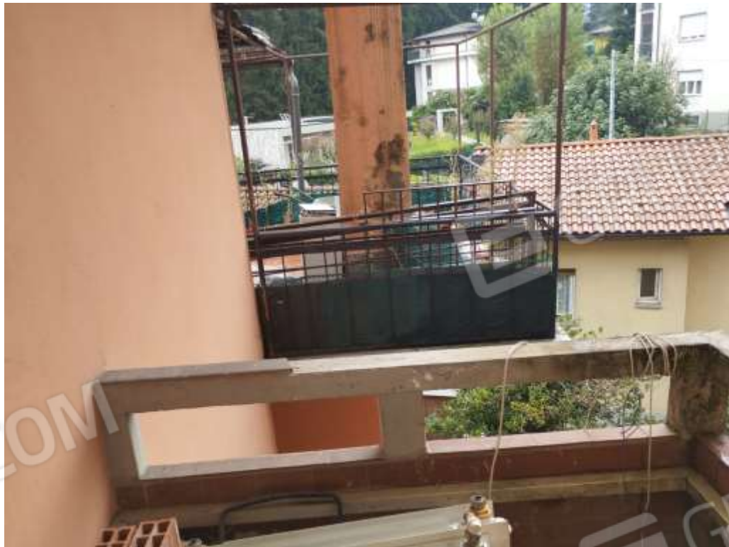
VISTA BALCONE E TERRAZZO
