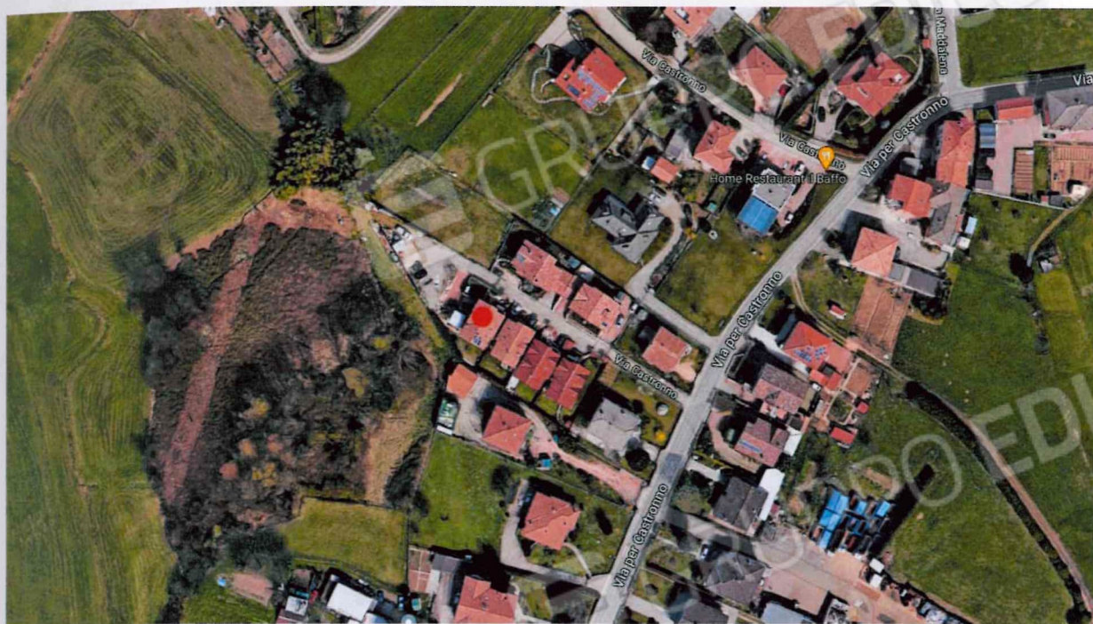
FOTOGRAFIA AEREA D'INSIEME (Google maps)
