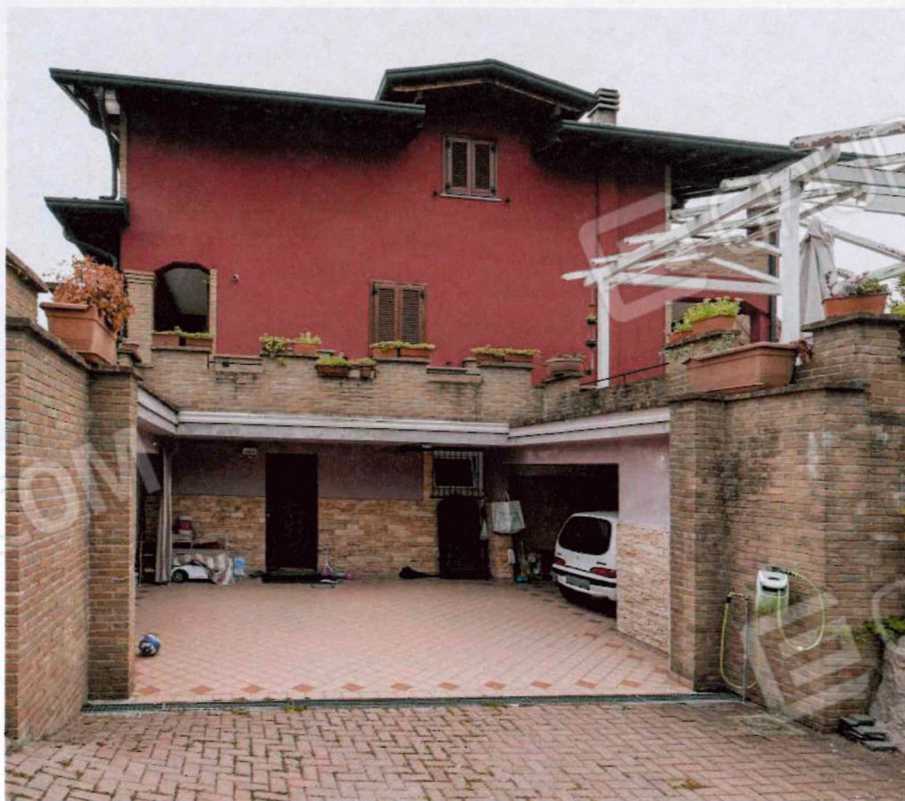
vista est (porzione seminterrata non sanabile e da demolire)
