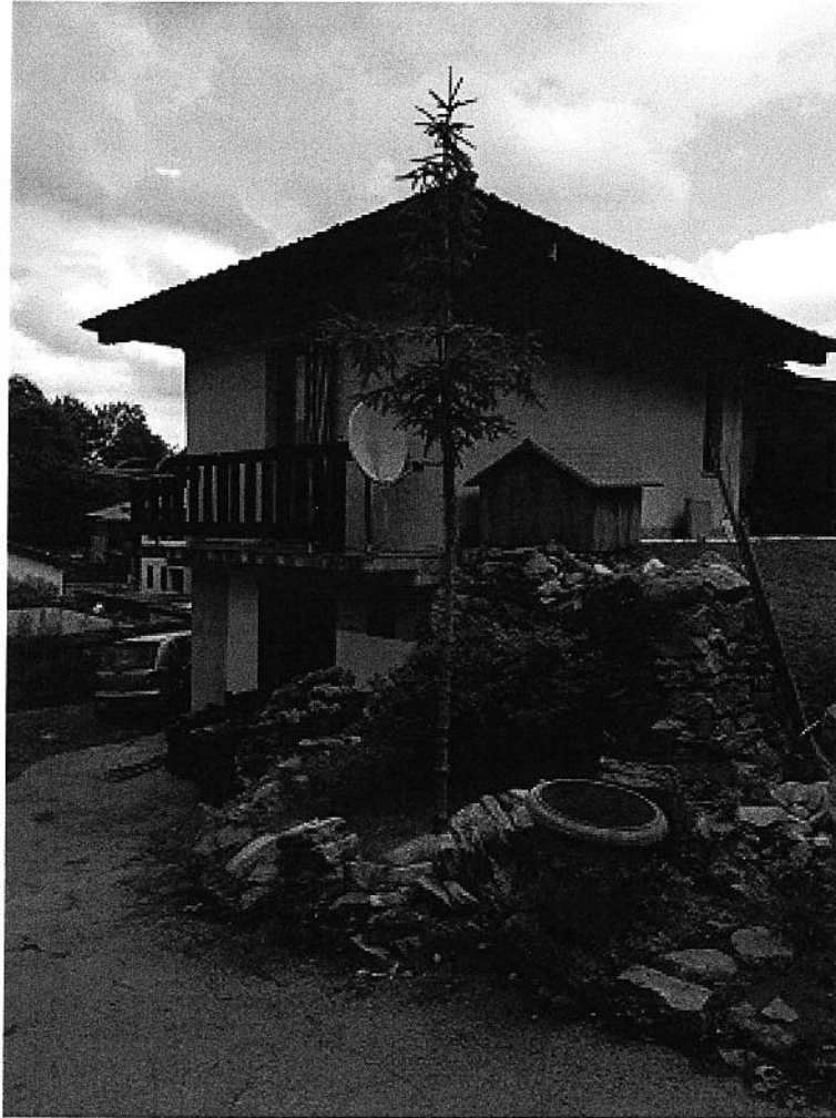
VISTA GENERALE DELL'EDIFICIO
