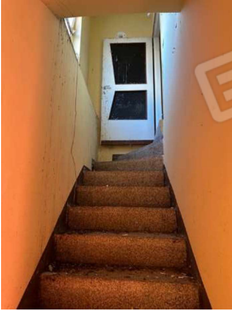
Scala interna da piano primo al piano secondo
