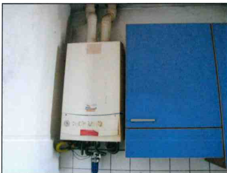
FOTO 26 U.I. MAPPALE 1312 SUB. 4 VISTA RIPRESA NEL LOCALE RIPOSTIGLIO DELLA CALDAIA A MURO E PARTE DI ANGOLO COTTURA.
