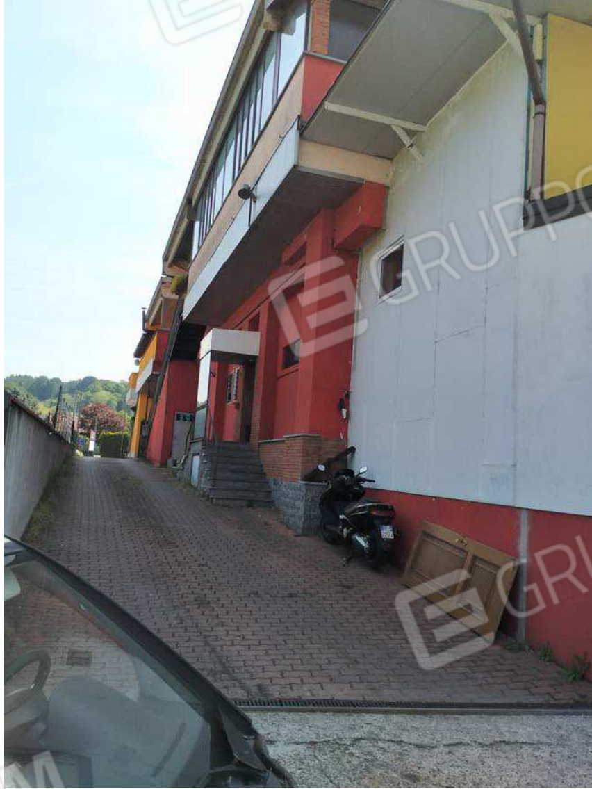
VISTA ESTERNA NORD
