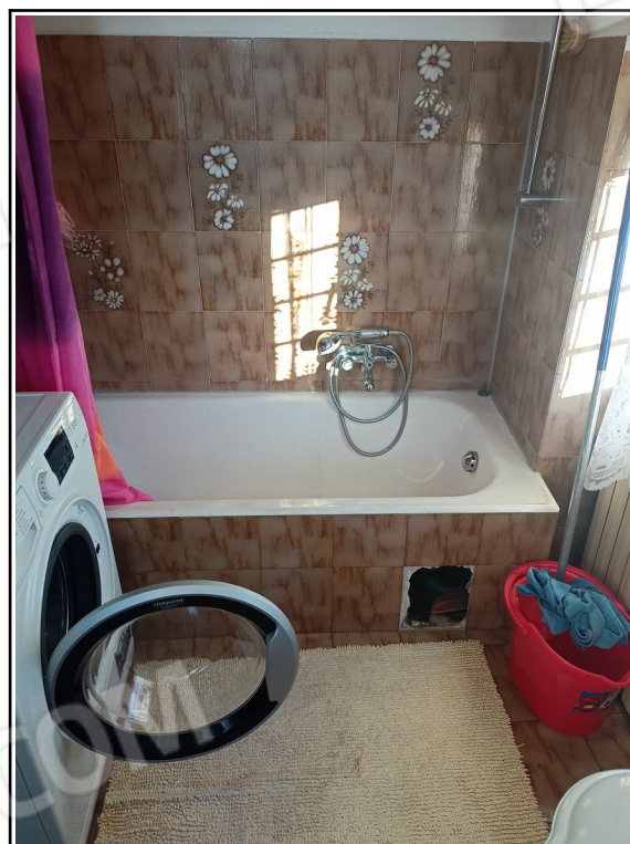
vista del bagno
