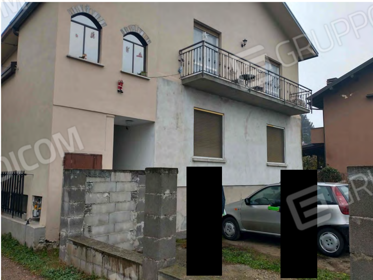
Vista esterna – facciata principale (ingresso e giardino)
