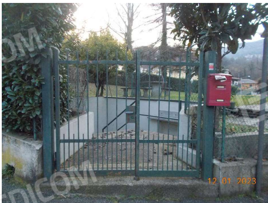
Foto 14 LOTTO 002 CORPO B Cancello di accesso all'area esterna
