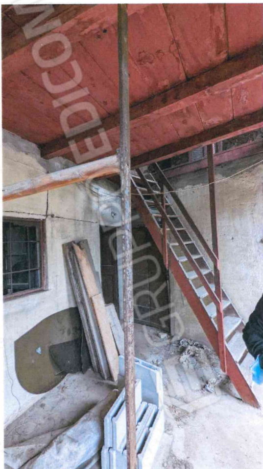
Ballatoio piano secondo
