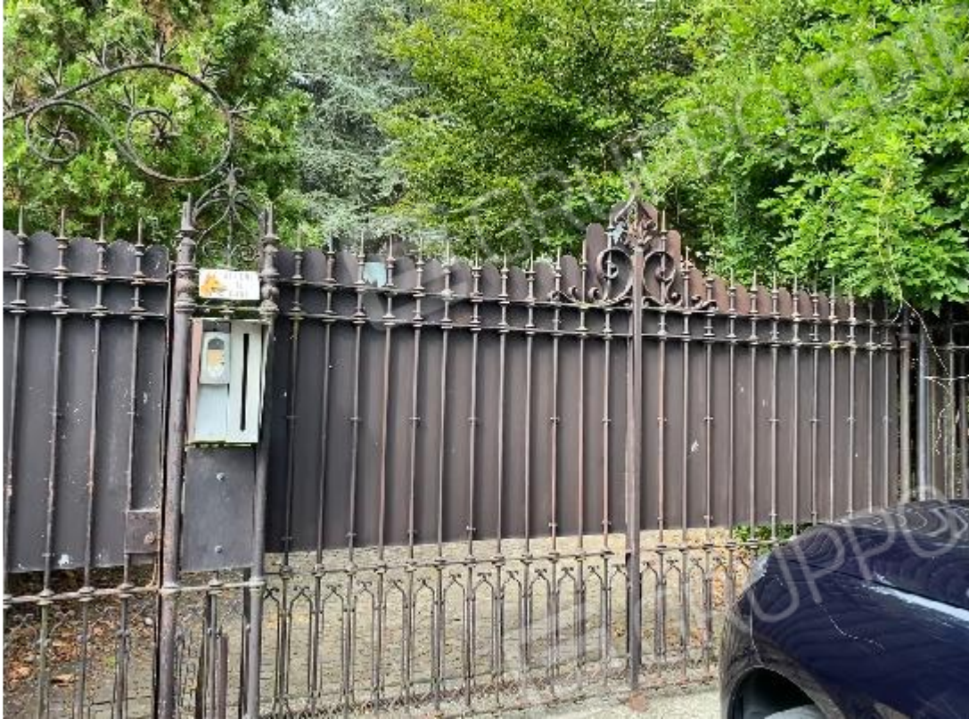
20. ingresso pedonale e carroia
