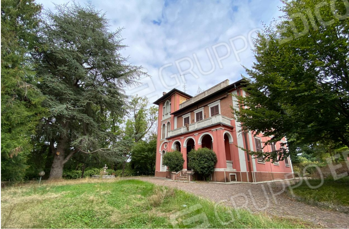
2. Villa vista da sud
