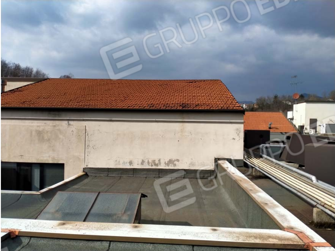
VISTA ESTERNA RIPOSTIGLIO P. 2°
