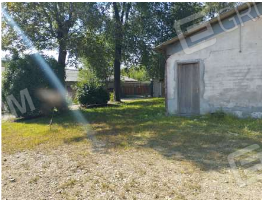
ACCESSO CARRAIO COMUNE
