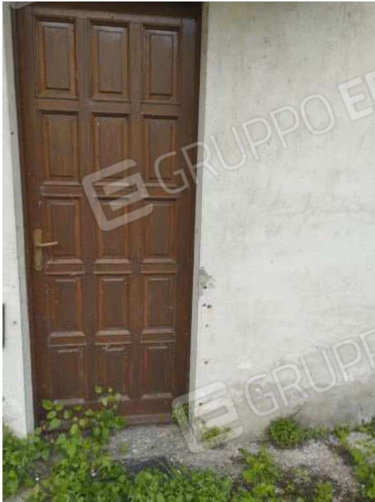
Particolare del portoncino di ingresso
