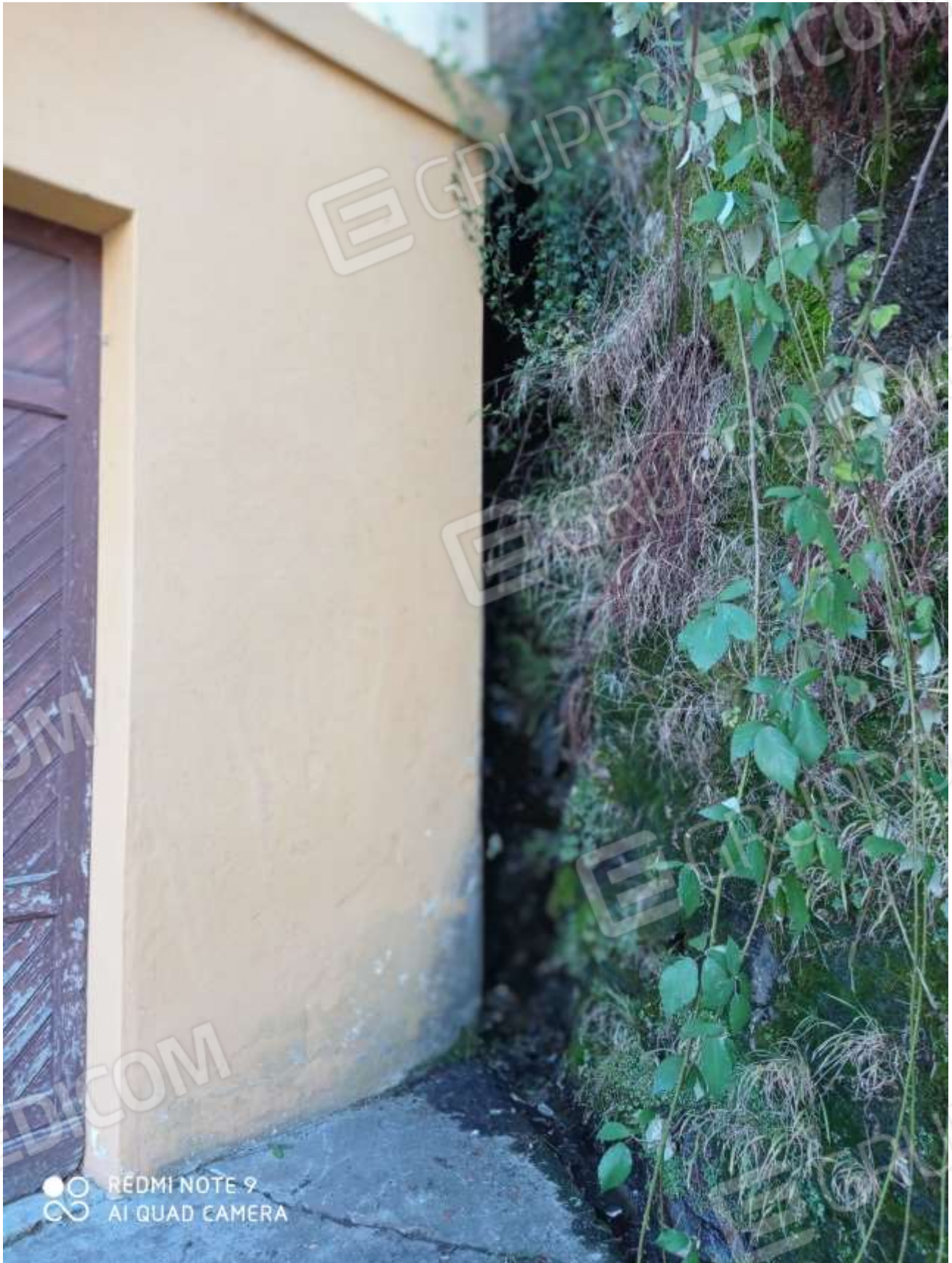
FOTO 8: il retro dell' autorimessa a ridosso della roccia
