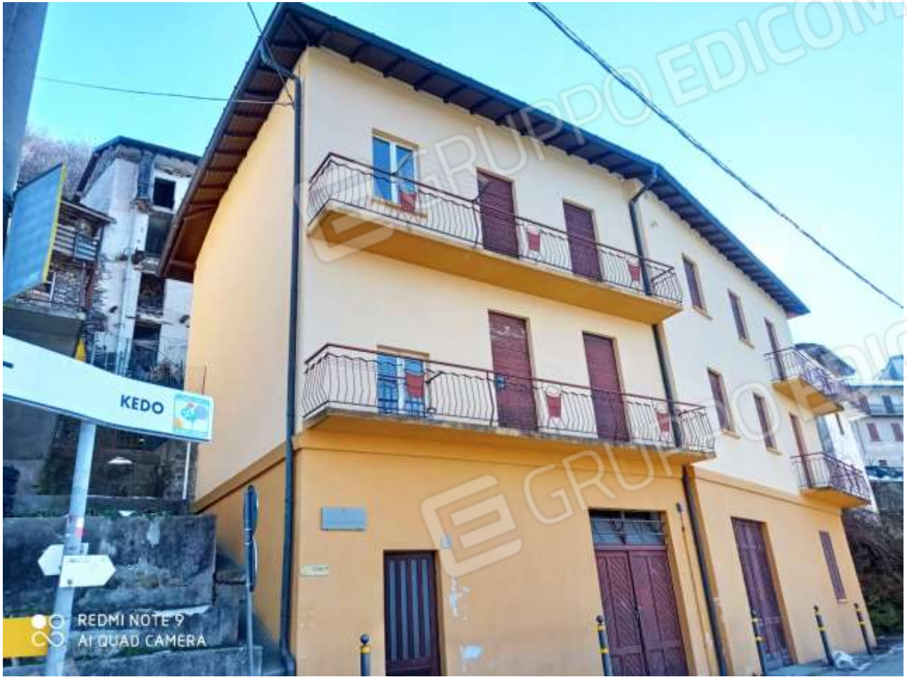
FOTO 2: la facciata sulla via Verdi
