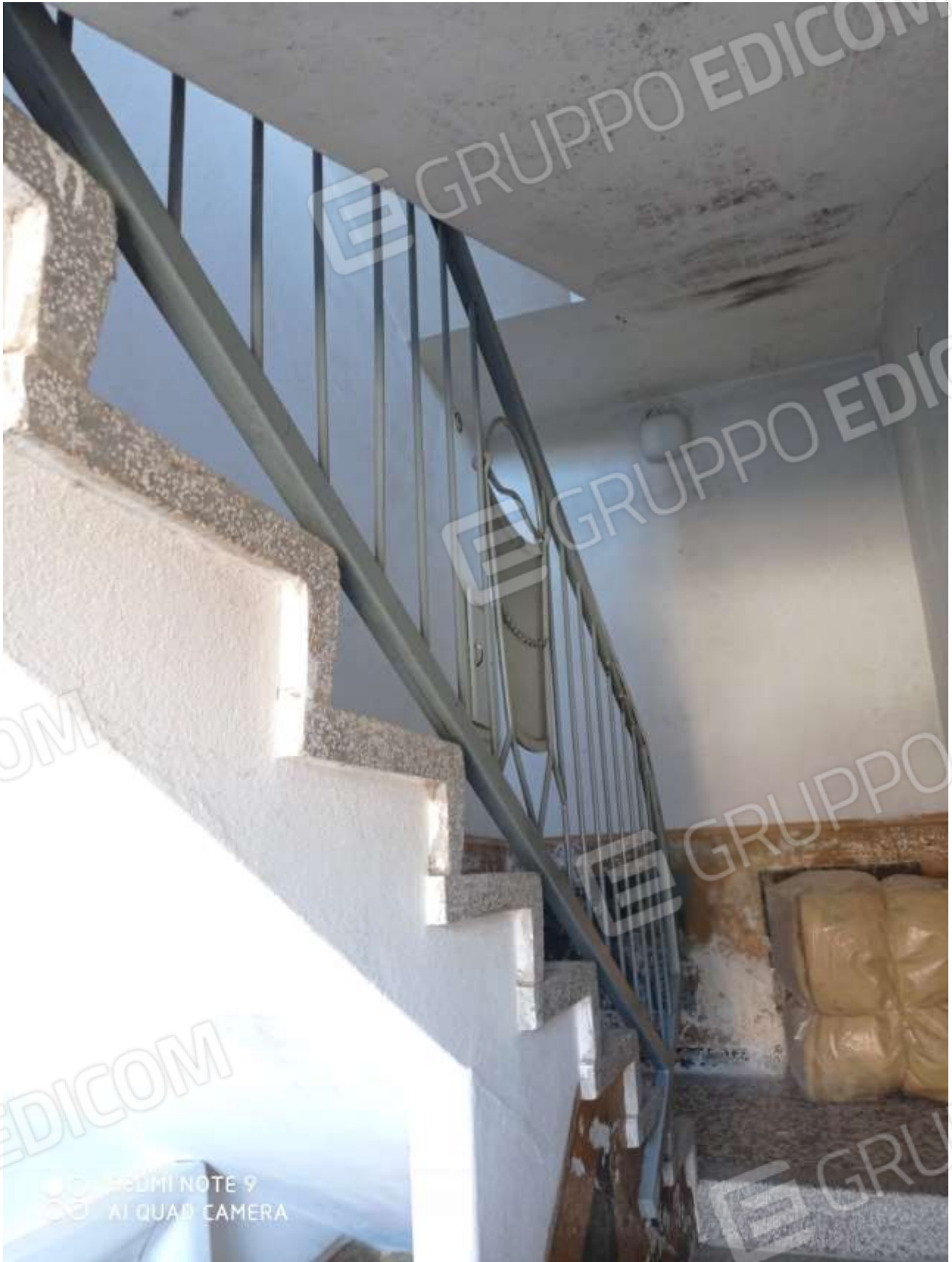
FOTO 11: il corpo scale al piano terreno con gradini di marmette di cemento
