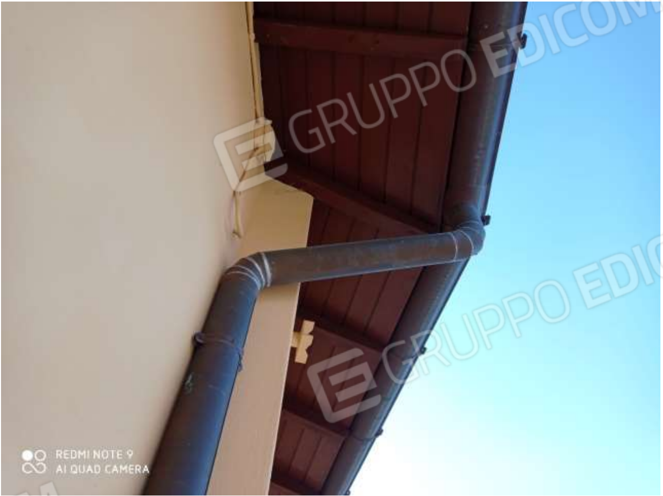
FOTO 31: vista dai balconi sulle lattonerie di rame apparentemente in buono stato
