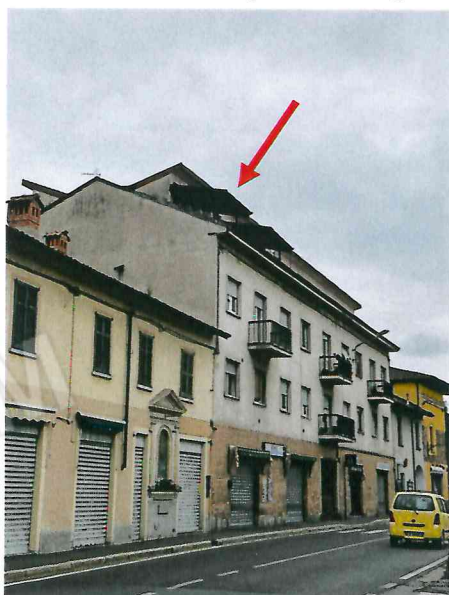
Lato edificio verso via Mauceri
