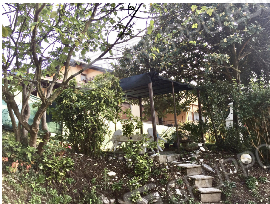
FOTO N. 3 PROSPETTO SUD CON ACCESSO DAL BOX AUTO
