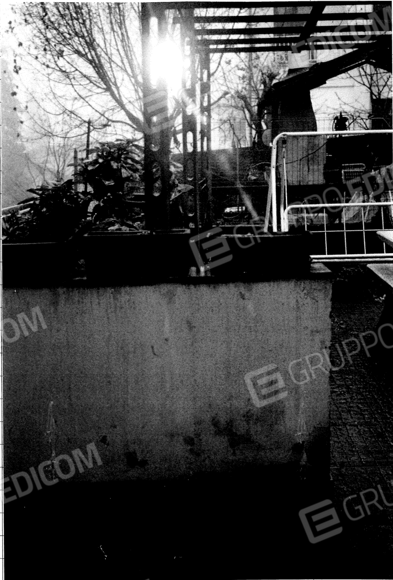
FOTO N. 17 – Cortile piano terra.
