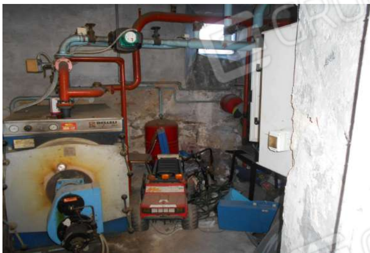
vecchio locale tecnico
