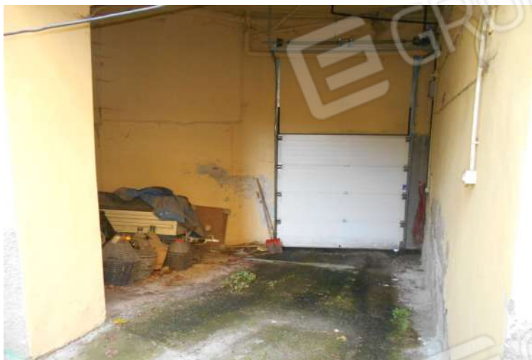
area ingresso carraio
