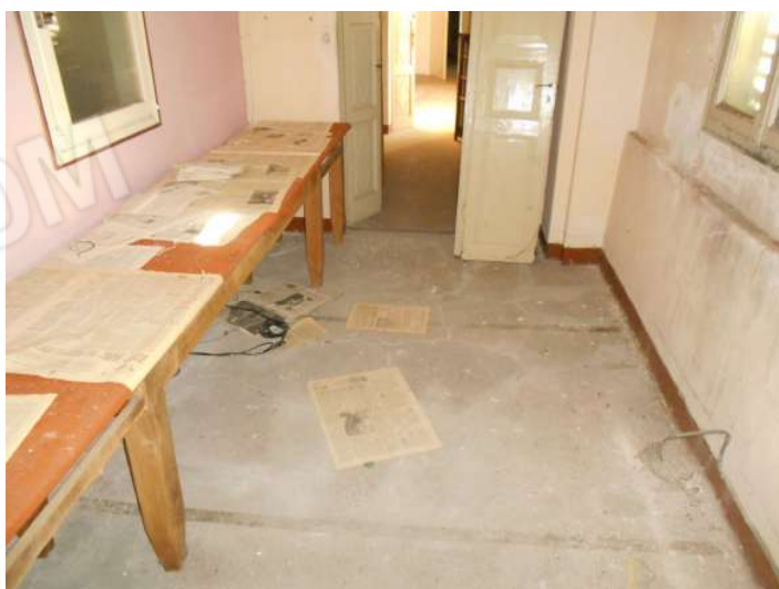
interni - secondo piano ristrutturato
