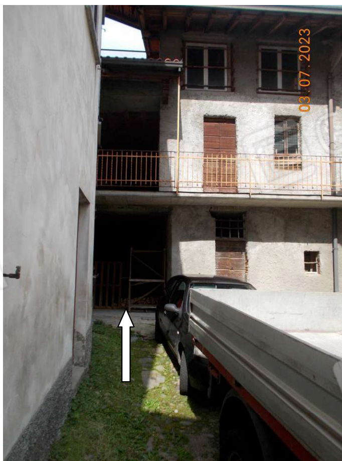
Foto 10 'corpo B' – ingresso cantina da corte comune
