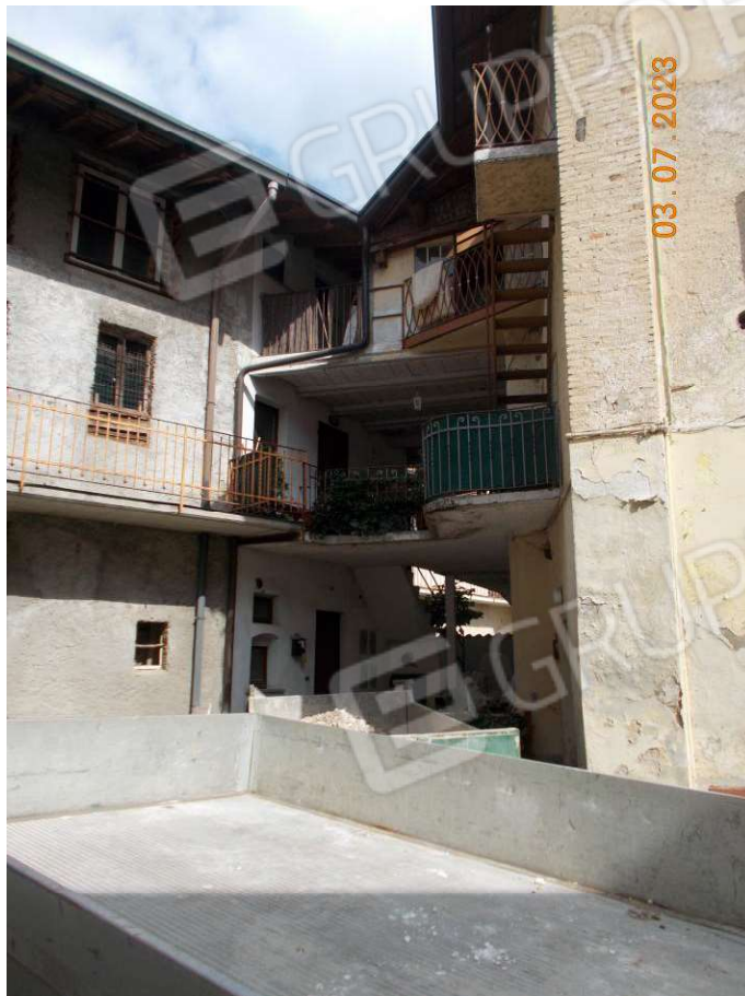
Foto 1 'corpo A' – ingresso corte
