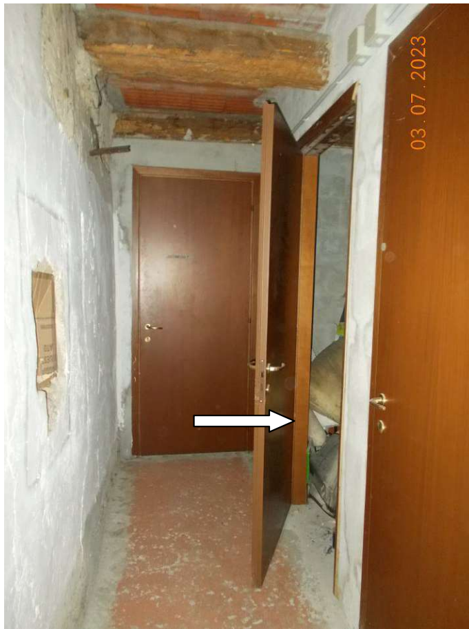
Foto 9 'corpo B' – ingresso cantina da corridoio comune
