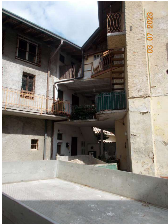
Foto 1 'corpo A' – ingresso corte
