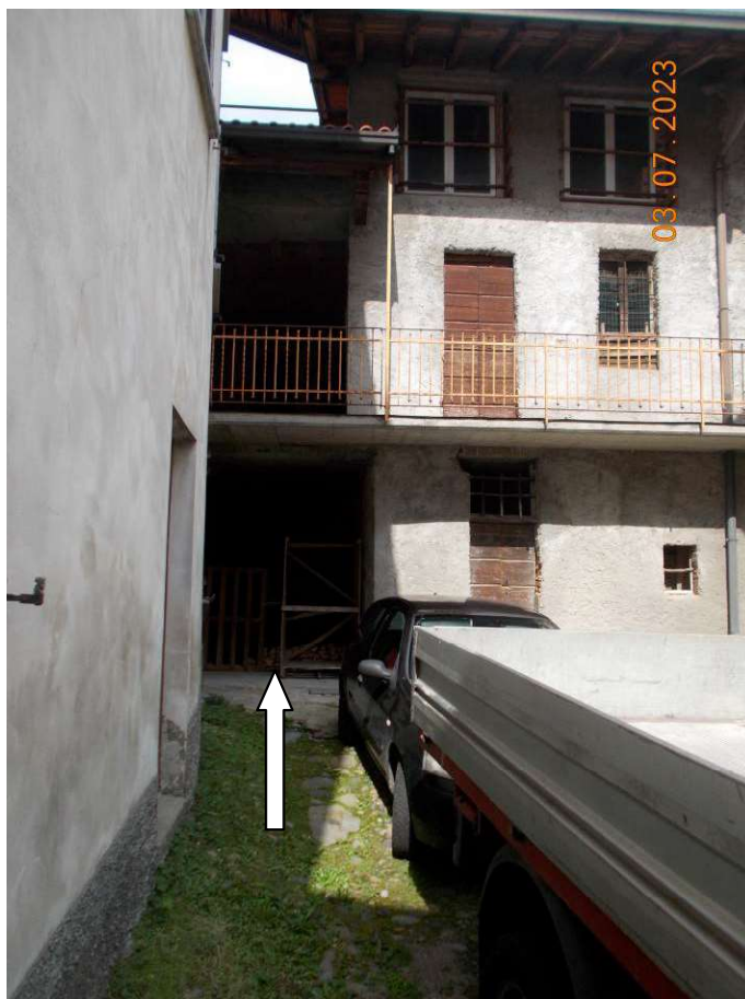
Foto 10 'corpo B' – ingresso cantina da corte comune
