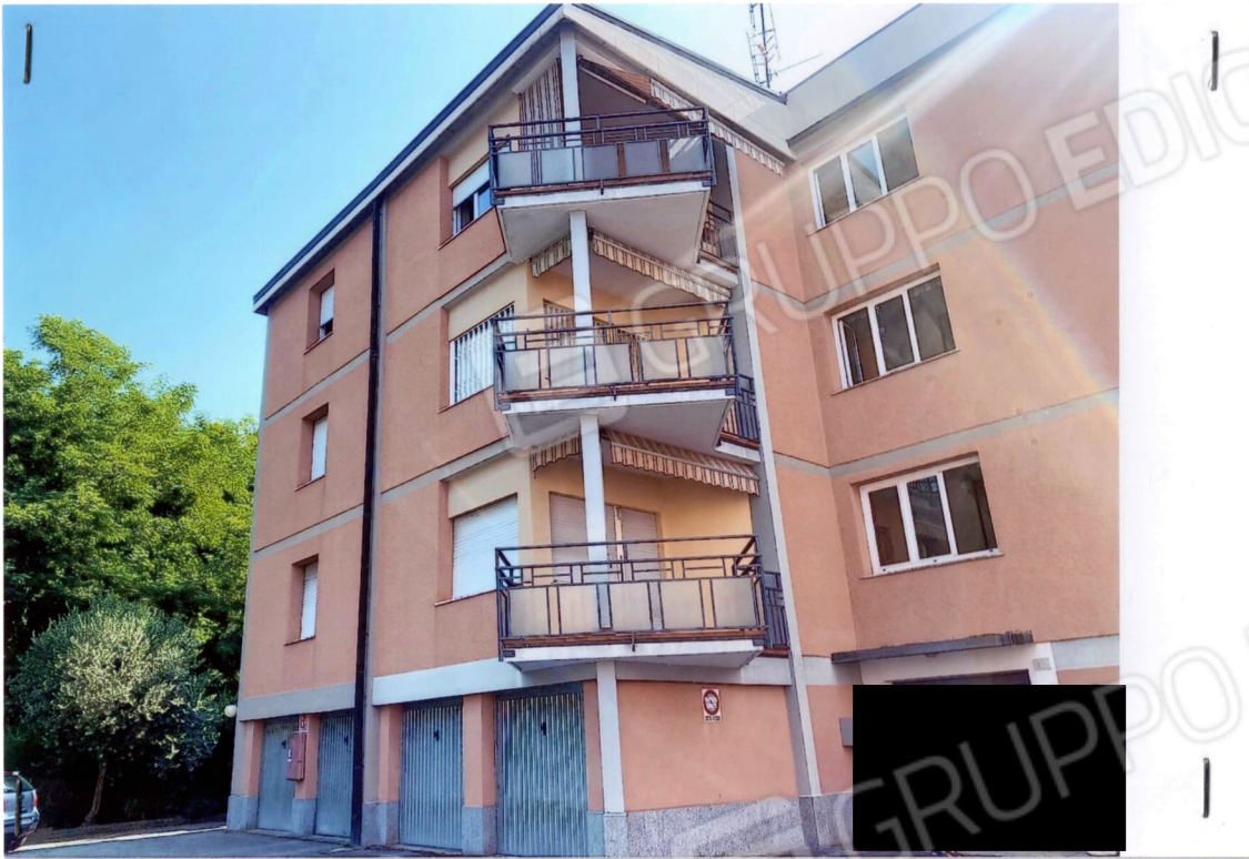
FOTO N. 1 – FACCIATA DEL CONDOMINIO
