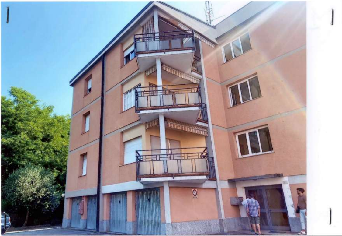
FOTO N. 1 – FACCIATA DEL CONDOMINIO
