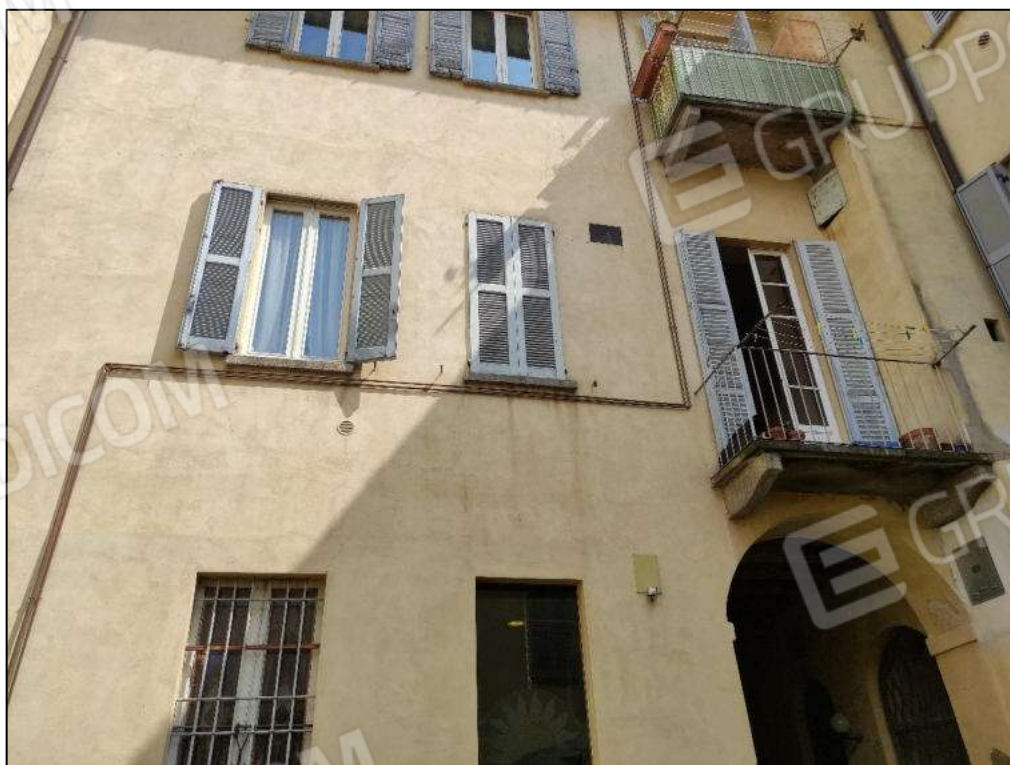
Prospetto su cortile interno
