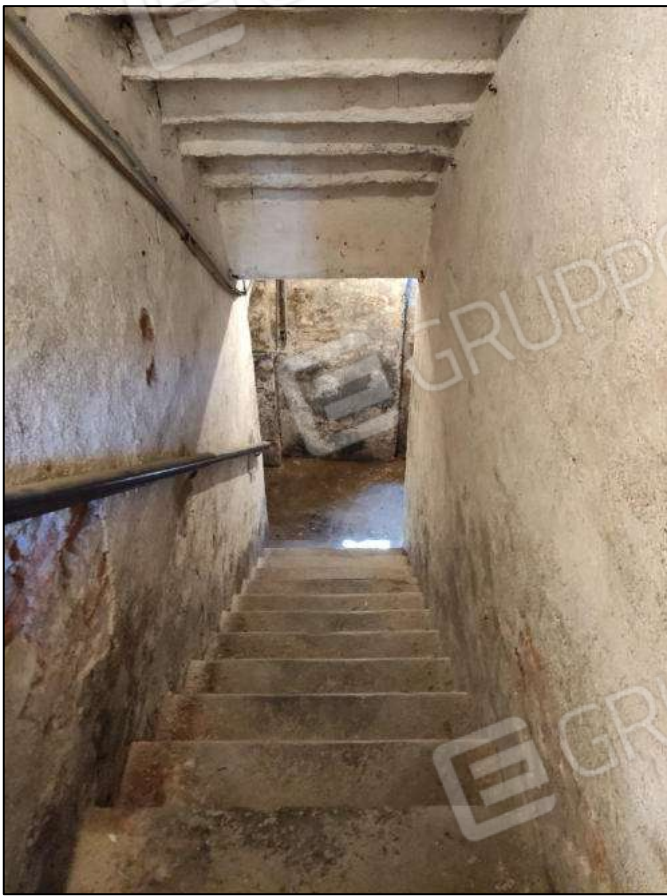
Scala di accesso alla cantina
