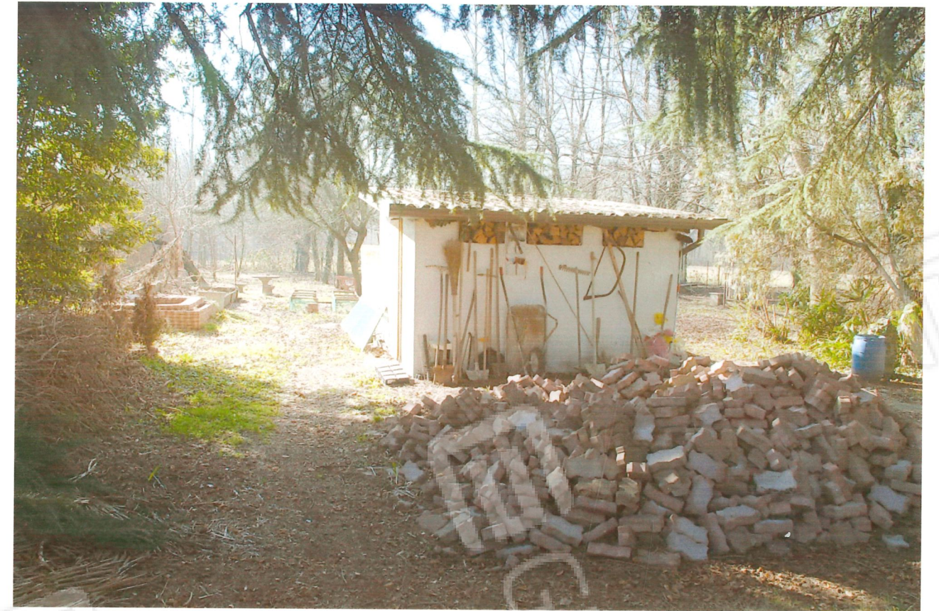
FOTO nr.5 - 6 Riprese della legnaia e dell'area oggetto di E.I.
