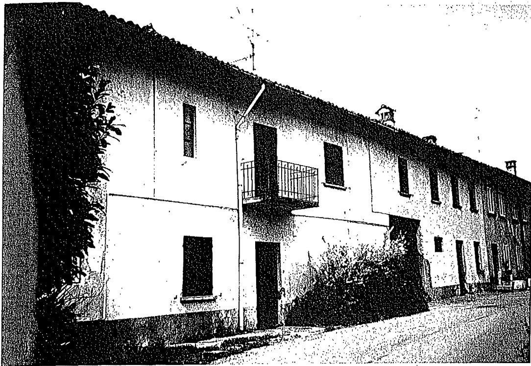
FOTO 1 - VISTA DELLA PORZIONE DI FABBRICATO OGGETTO DI PROCEDURA ESECUTIVA, RIPRESA DALLA VIA PIAVE. LA FOTO RIPRENDE LA PORZIONE CHE COMPRENDE L'U.I. DISTINTA CON IL MAPPALE 115 SUB. 5 (A SINISTRA DELLA FOTO) E 118 SUB. 4 (A DESTRA DELLA FOTO).
