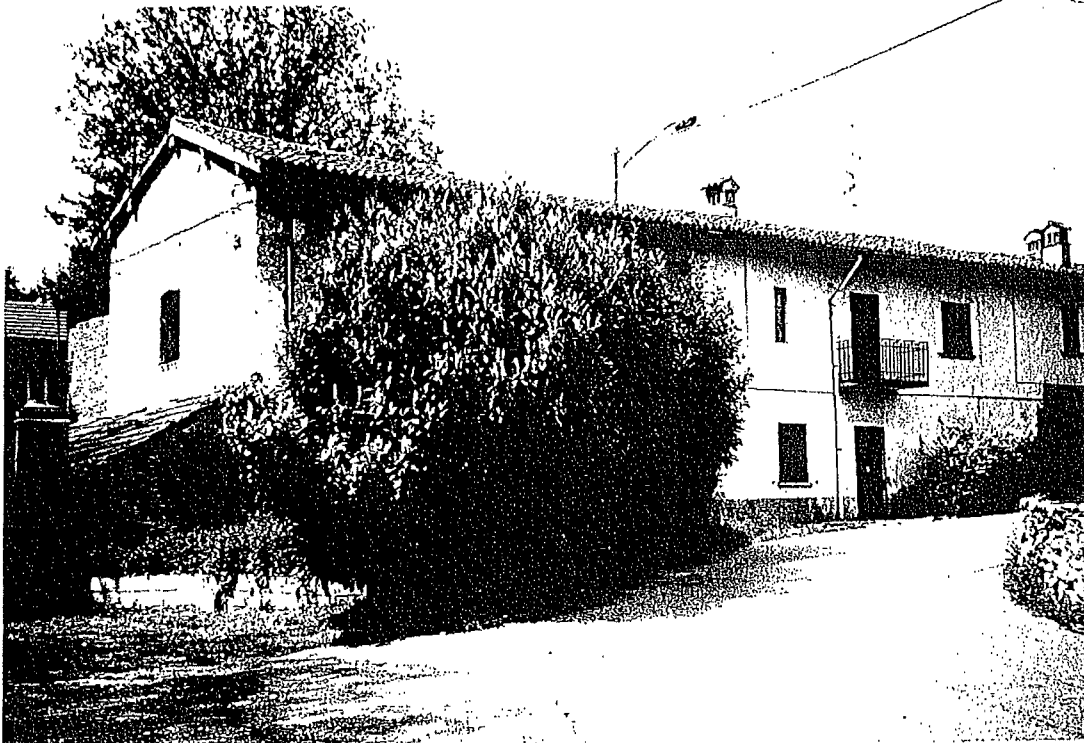
FOTO 2 - ALTRA VISTA DELLA PORZIONE DI FABBRICATO OGGETTO DI PROCEDURA ESECUTIVA, RIPRESA DALLA VIA PIAVE. LA FOTO RIPRENDE LA PORZIONE CHE COMPRENDE L'U.I. DISTINTA CON IL MAPPALE 115 SUB. 6 (A SINISTRA DELLA FOTO) E 115 SUB. 5 (A DESTRA DELLA FOTO).
