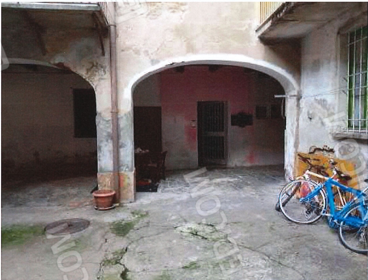
Vista del cortile interno di proprietà comune
