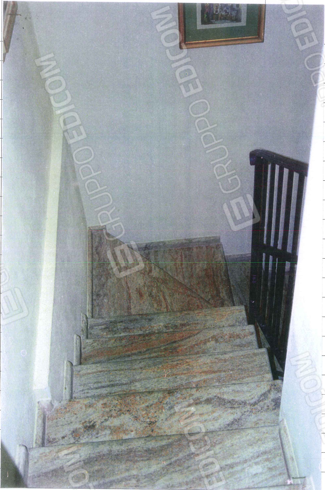
FOTO N. 21 – Scala di accesso alla taverna e cantina.
