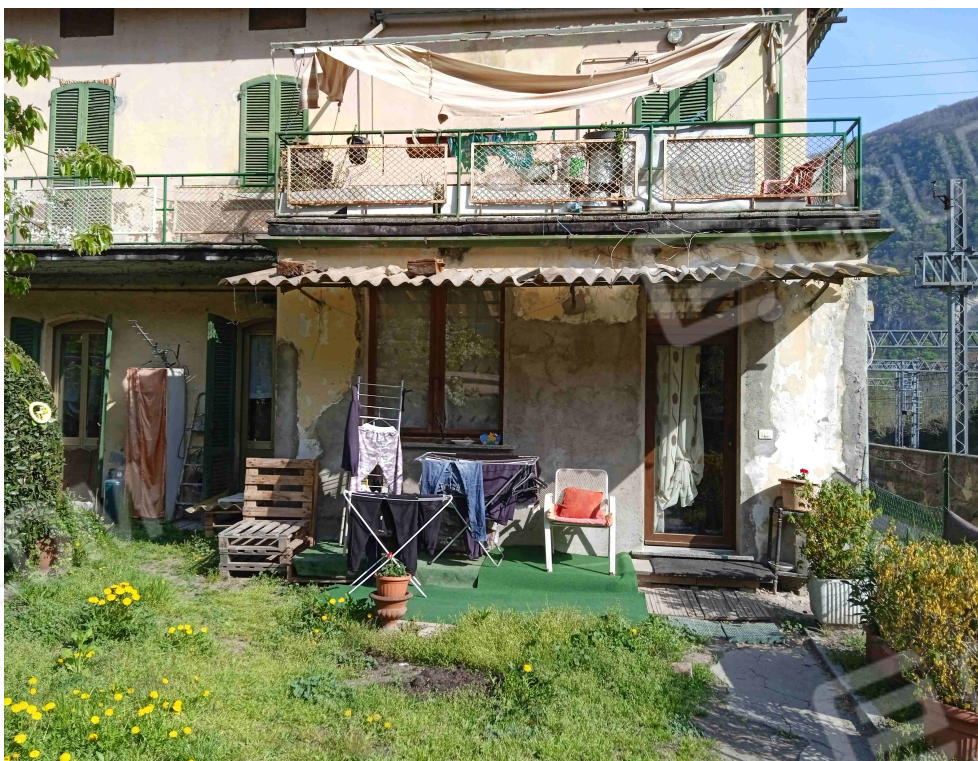
FOTO N.2 –Prospetto Sud con ingresso da area pertinenziale
