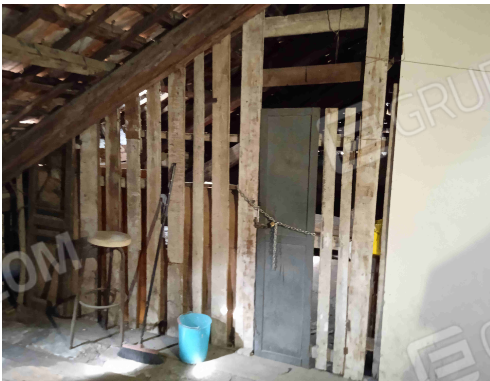
Foto n.8 Accesso al sottotetto di proprietà
