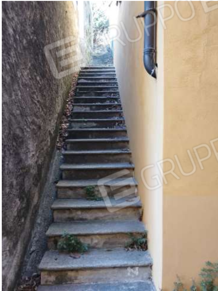
VIA PEDONALE DI ACCESSO
