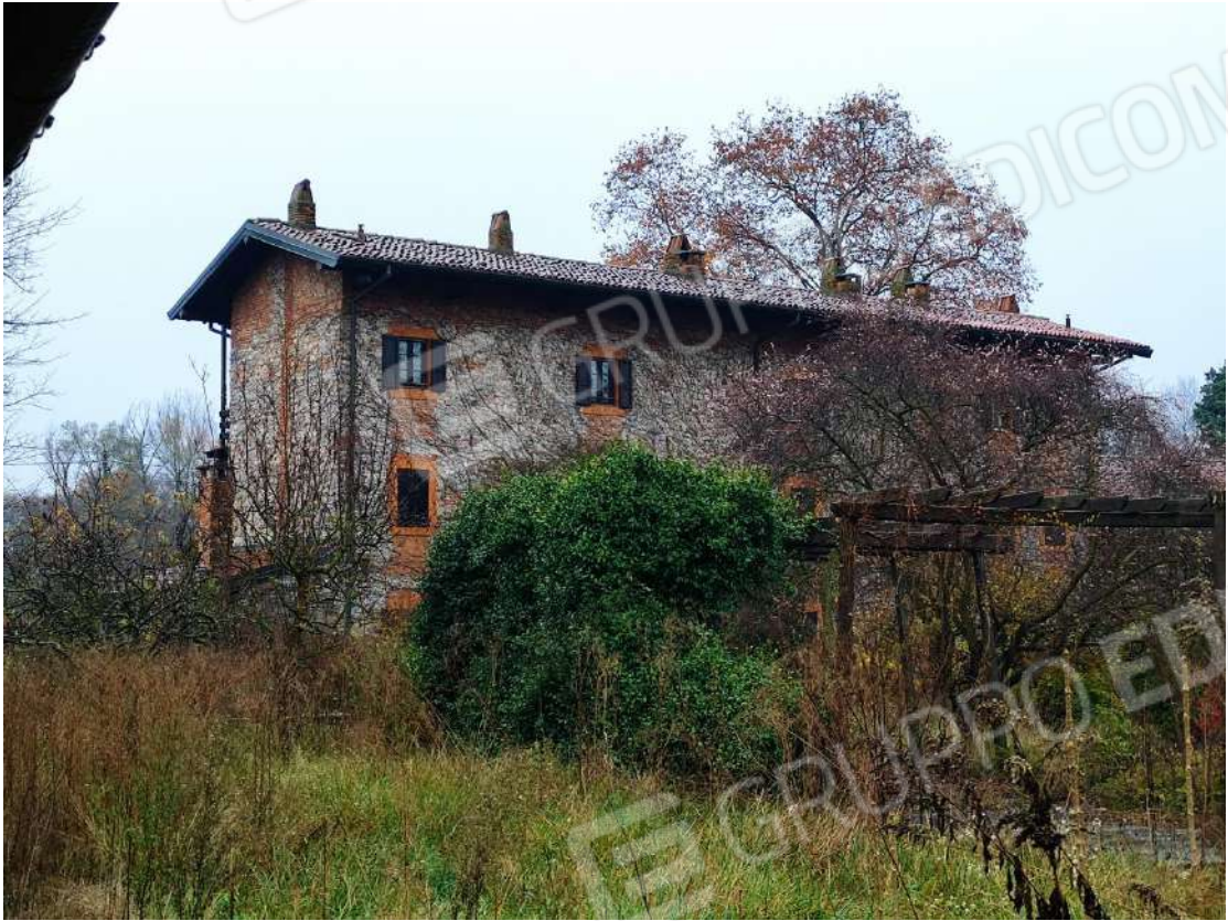
Vista esterno fabbricato
