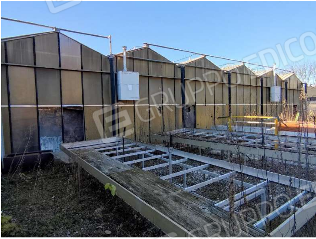
Vista esterno fabbricato
