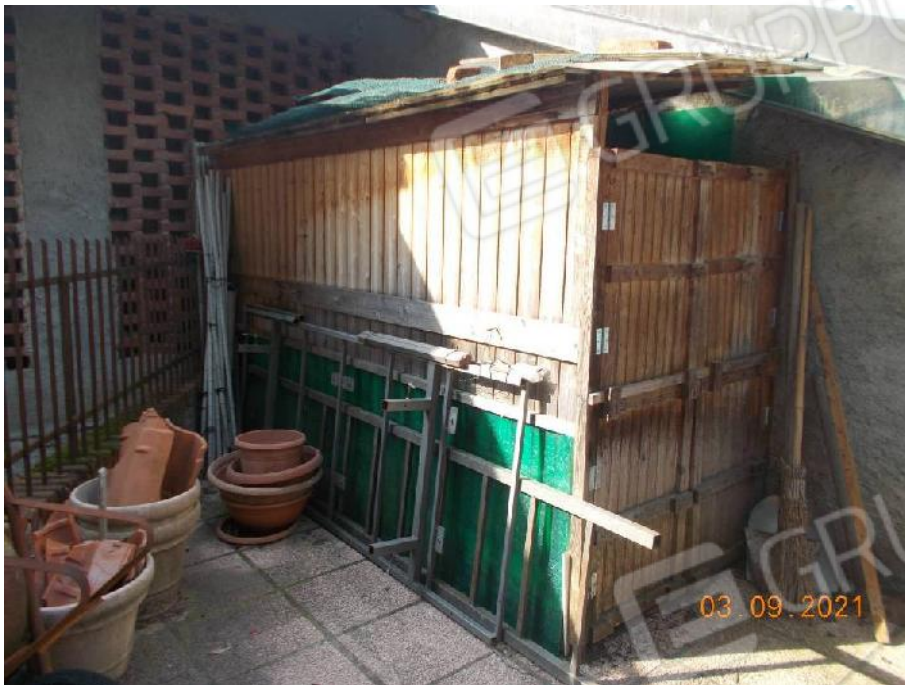
Foto 8 Manufatto accessorio P1
