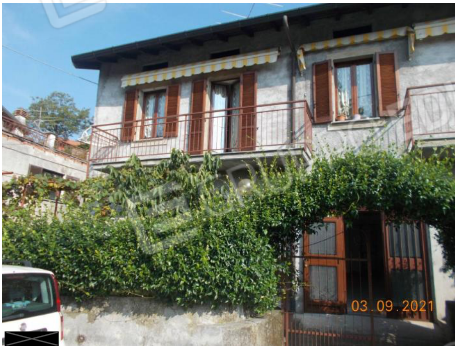
Foto 1 Ingresso abitazione e autorimessa
