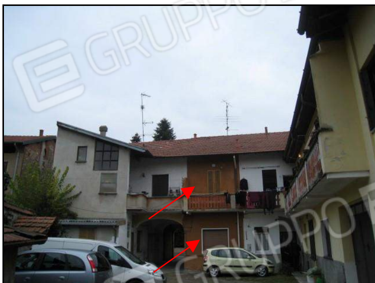
FOTO 5 VISTA RIPRESA DAL CORTILE COMUNE DEL FABBRICATO CHE COMPENDIA LA PORZIONE DI ABITAZIONE IDENTIFICATA DAL MAPPALE 1458 SUB. 1 OGGETTO DI PROCEDURA ESECUTIVA (LA CUI UBICAZIONE È INDICATA CON LE FRECCE ROSSE).
