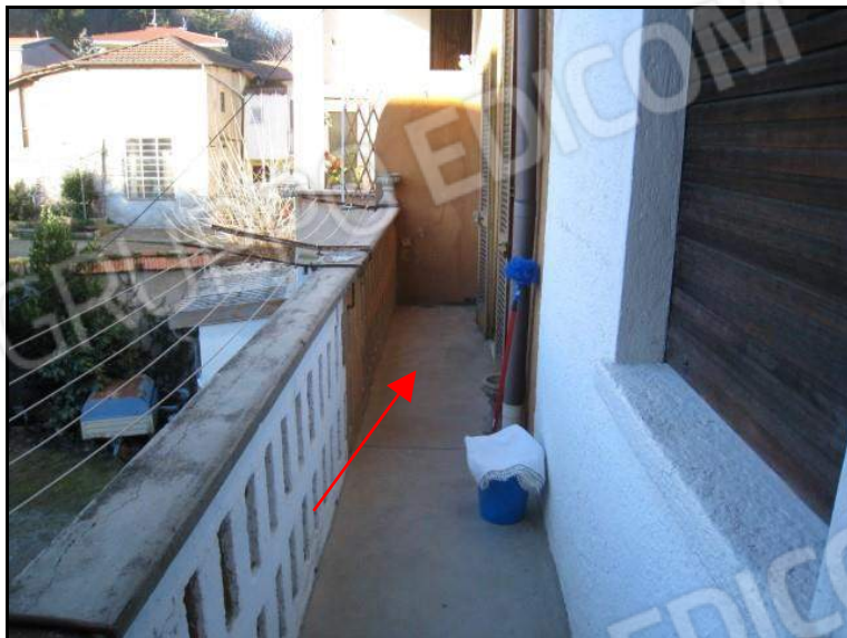
FOTO 19 PIANO PRIMO PORZIONE DI ABITAZIONE U.I. MAPPALE 1458 SUB. 1 VISTA RIPRESA VERSO SUL BALCONE DI PROPRIETA' (INDICATO CON LA FRECCIA ROSSA).
