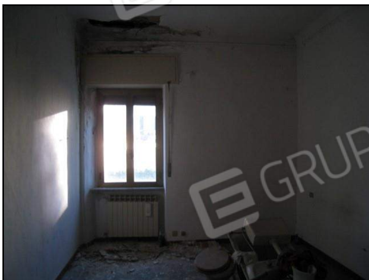
FOTO 21 PIANO PRIMO PORZIONE DI ABITAZIONE U.I. MAPPALE 1458 SUB. 1 VISTA RIPRESA NELL'ALTRA CAMERA.
