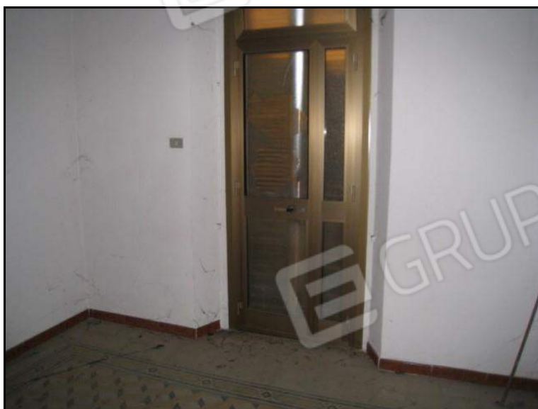
FOTO 18 PIANO PRIMO PORZIONE DI ABITAZIONE U.I. MAPPALE 1458 SUB. 1 VISTA DI UNA CAMERA.
