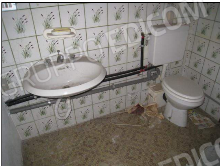
FOTO 13 PIANO TERRA PORZIONE DI ABITAZIONE U.I. MAPPALE 1458 SUB. 1 VISTA RIPRESA ALL'INTERNO DEL BAGNO.
