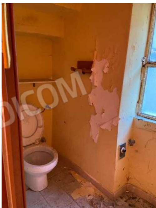
Wc piano primo
