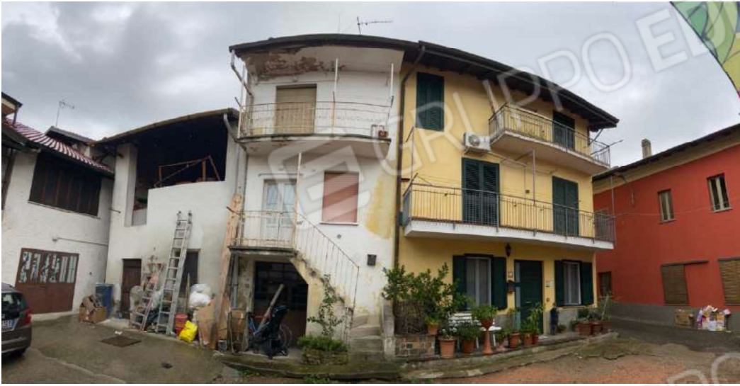
Foto 1: affaccio principale su corte interna lato ovest
