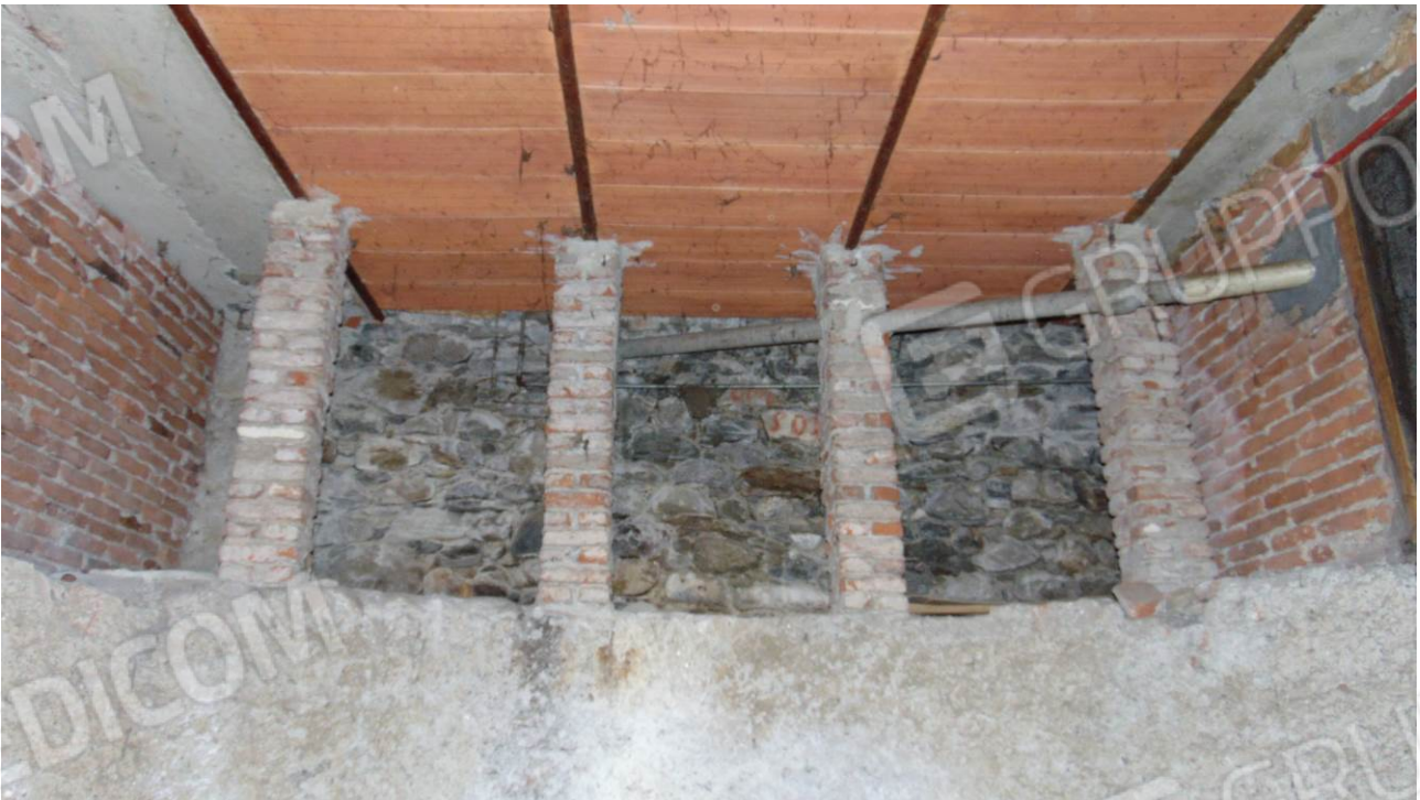
Foto 13: dettaglio intradosso locale ripostiglio prospiciente l'accesso
