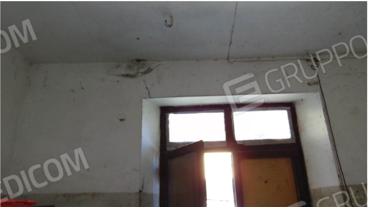
Foto 15: dettaglio intradosso sopra portoncini d'accesso
