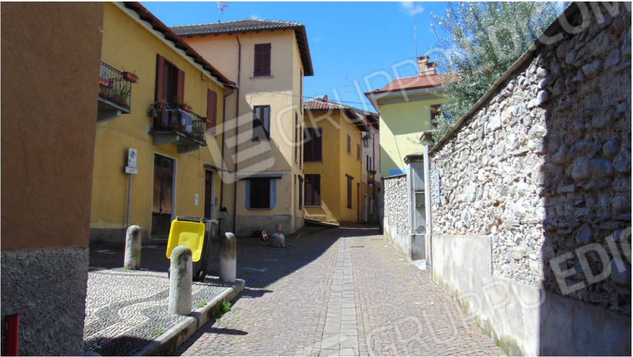
Foto 3: fabbricato in oggetto a sinistra, XXXXXXXXXXstrada locale in Zona A
