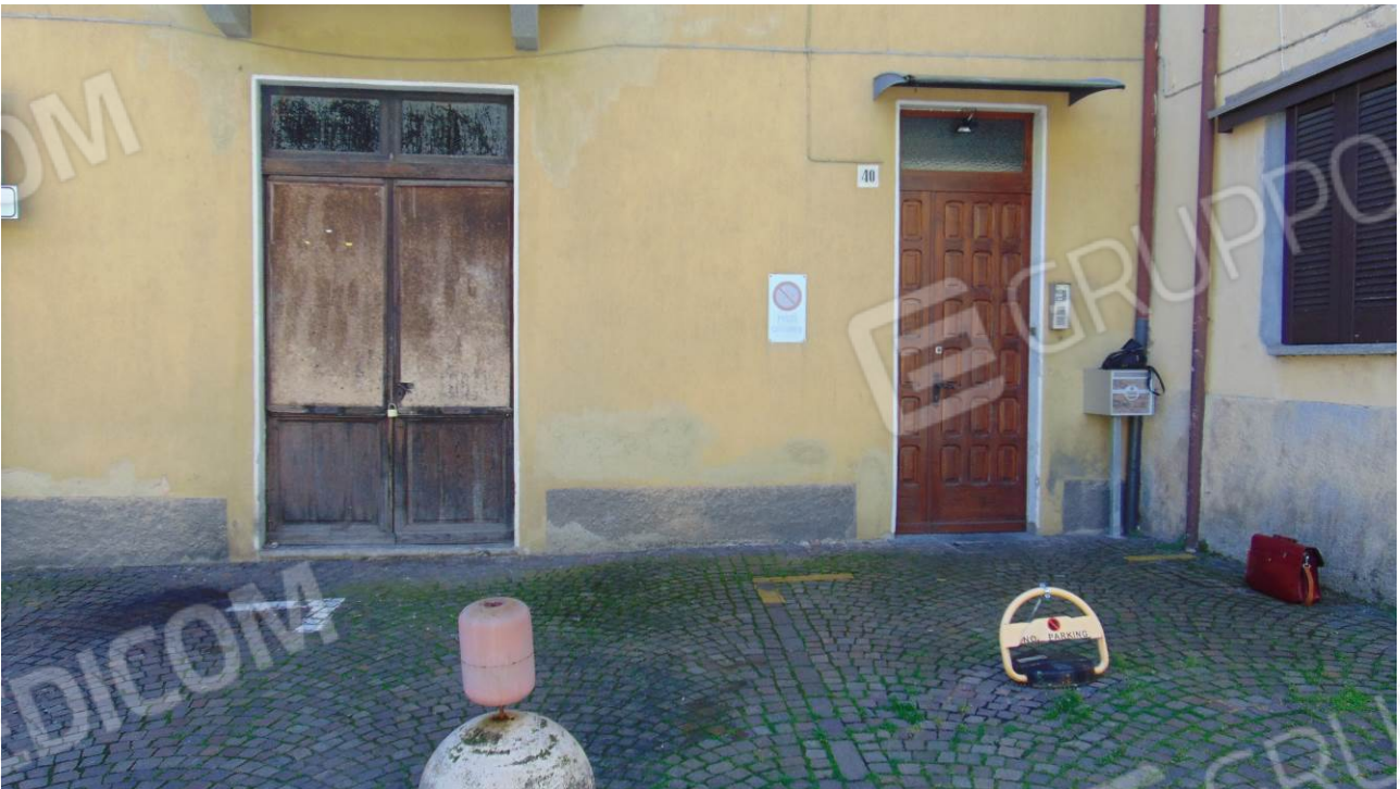
Foto 4: accesso porta a sinistra, adiacente accesso all'appartamento al piano primo
