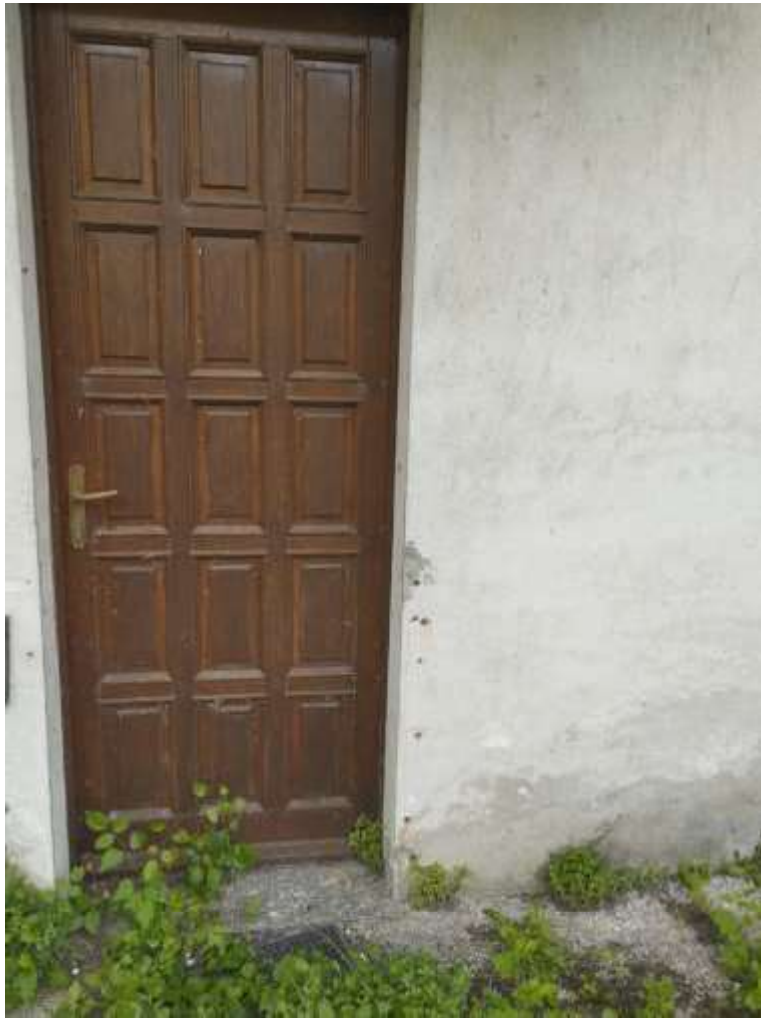
Particolare del portoncino di ingresso
